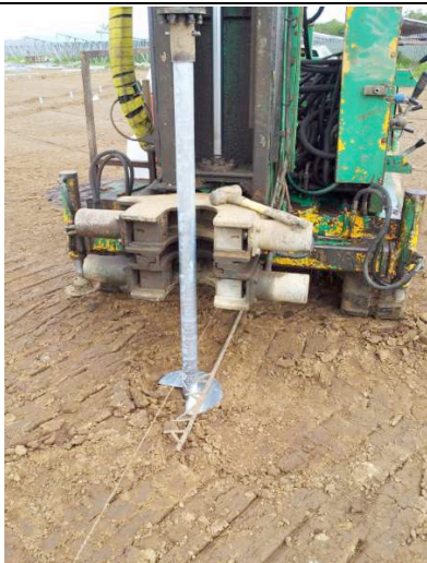
Foto 2) Perforación para el anclaje
