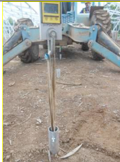
Foto 3) Anclaje instalado
