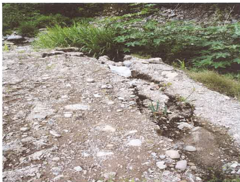
Foto 2. Fractura en la parte posterior de la construcción.
