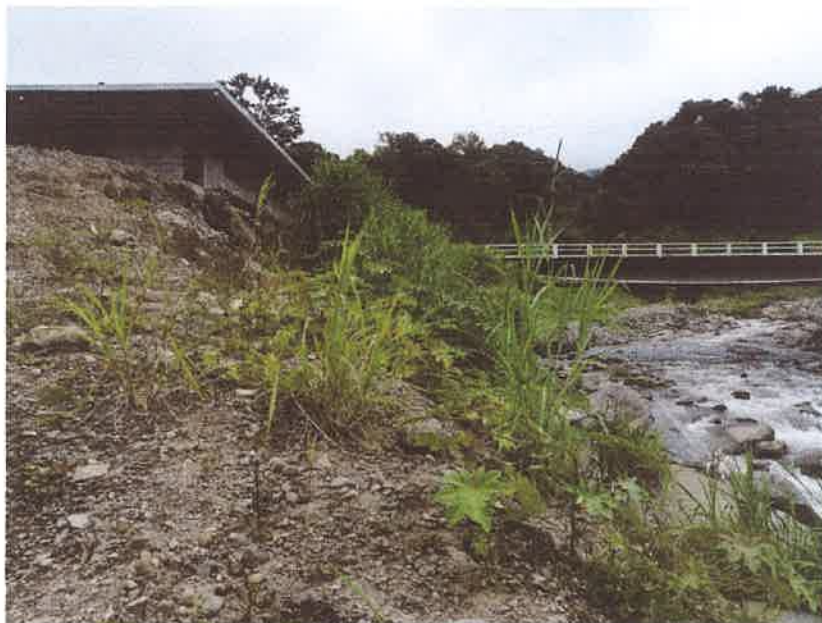
Foto 1. Diferencia de altura entre el nivel del río Chiriquí Viejo y la estructura.
