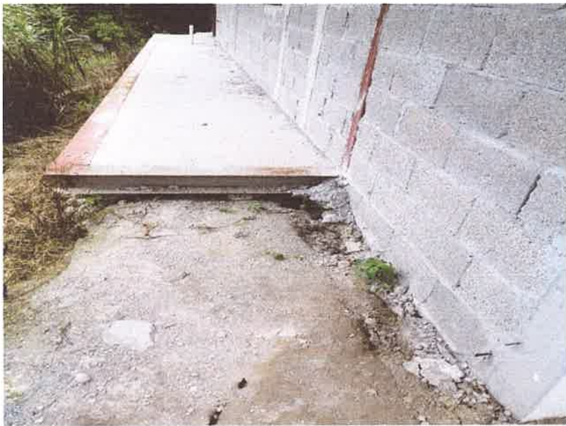
Foto 4. Terreno erosionado por la esorrentía superficial.
