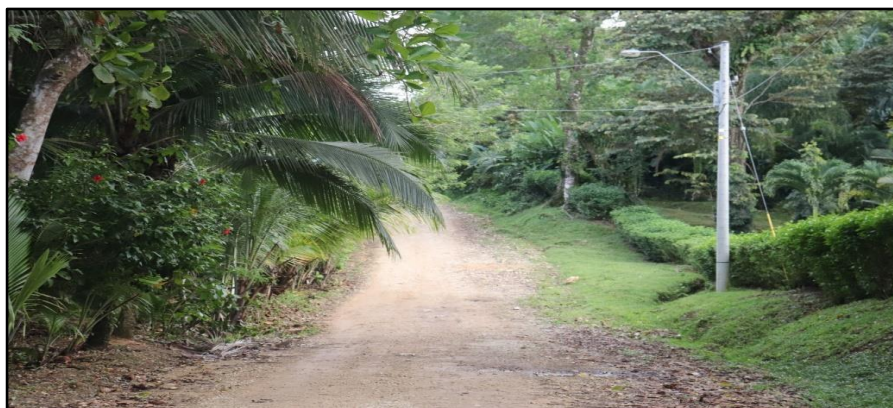
Ilustración 54 Último poste instalado en dirección a Playa Bluff
