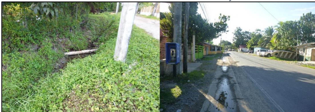
Ilustración 64 Cunetas: Tramo La Feria – Playa Paunch
