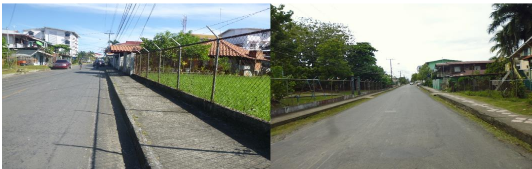
Ilustración 55 Aceras en buen estado.
