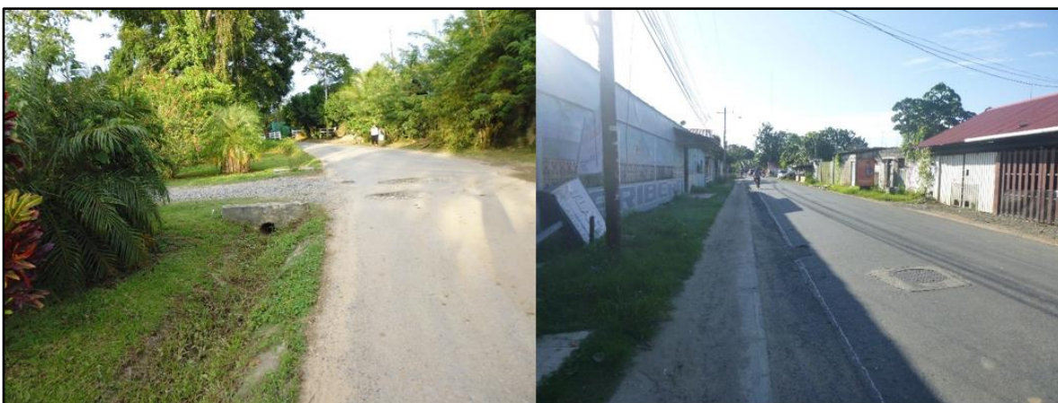
Ilustración 62 Carpeta Asfáltica: Tramo La Feria – Playa Paunch
