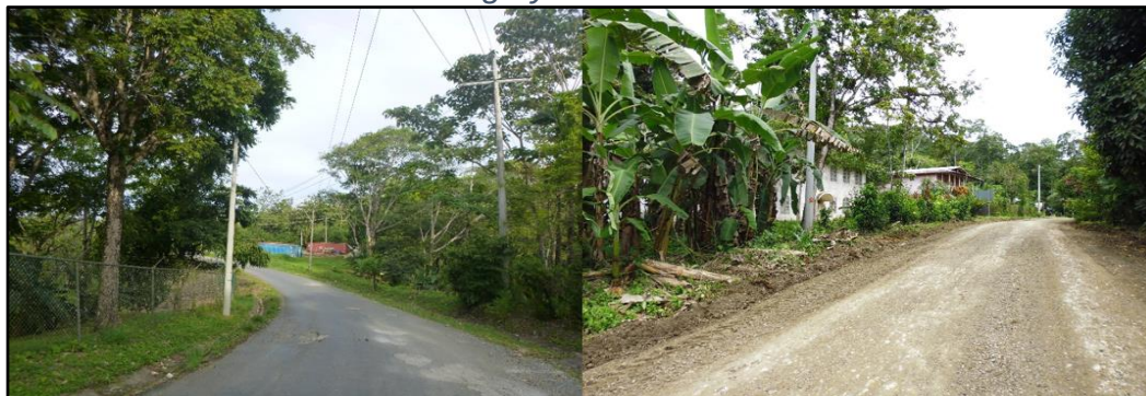
Ilustración 69. Vía en Boca del Drago y vía desde Isla Colón hacia Boca del Drago
