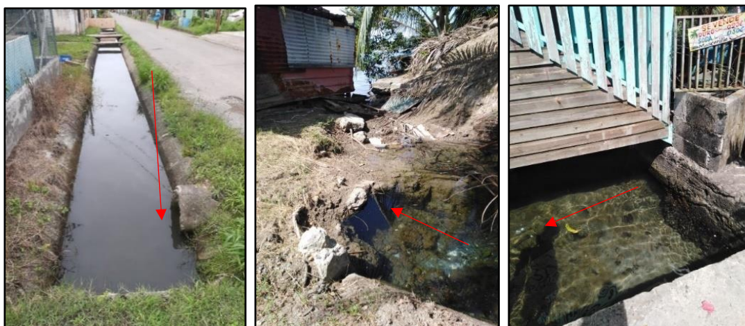
Ilustración 2. Canal de aguas pluviales de Calle 6ta interna.
