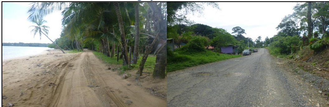
Ilustración 68 Vía en Boca del Drago y vía desde Isla Colón hacia Boca del Drago
