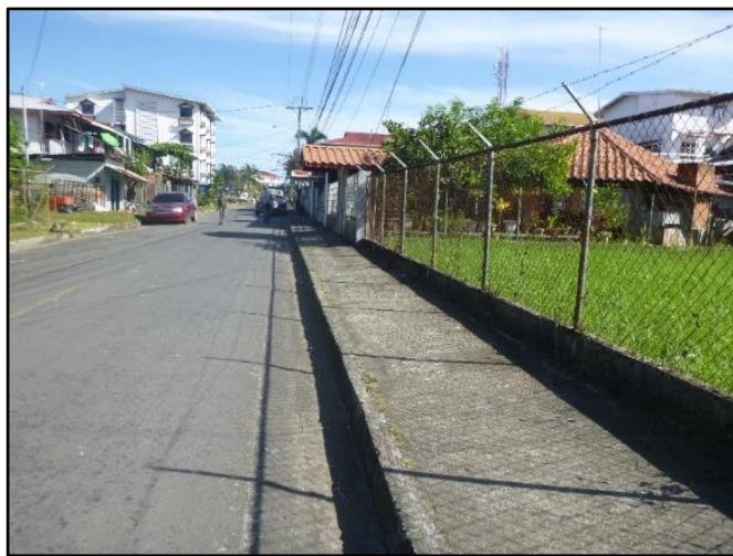
Ilustración 109. Aceras en buen estado. Calles internas de Isla Colón.
