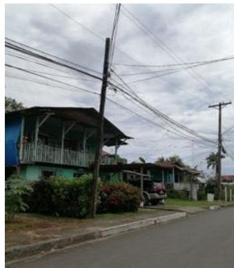
Ilustración 35. Tendido eléctrico en Avenida A y E respectivamente, tanto en postes de madera como de hormigón.
