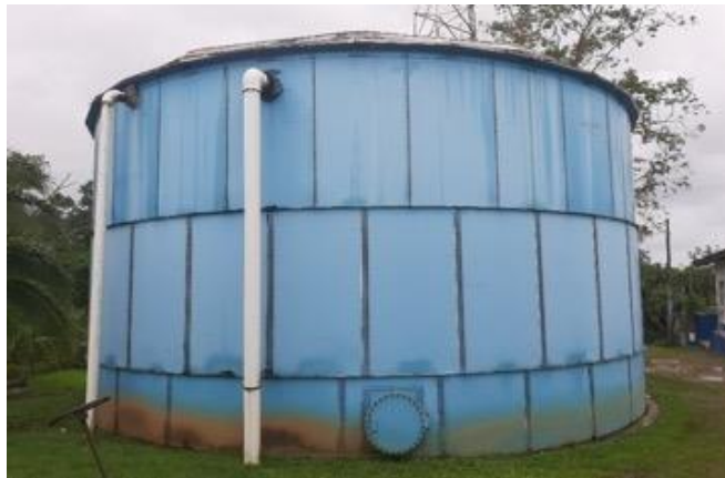
Ilustración 19. Tanque de reserva de 200,000 galones.
