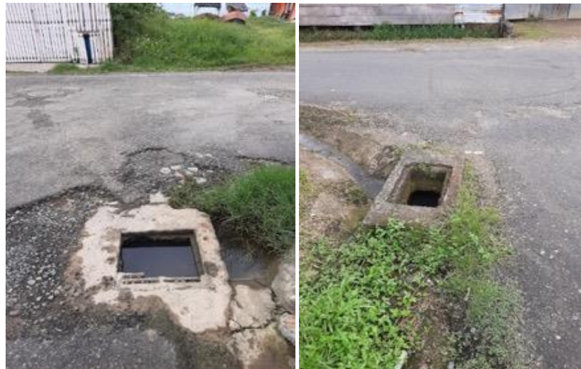
Ilustración 3. Cajas de inspección con agua estancada y sin parilla, calles internas.
