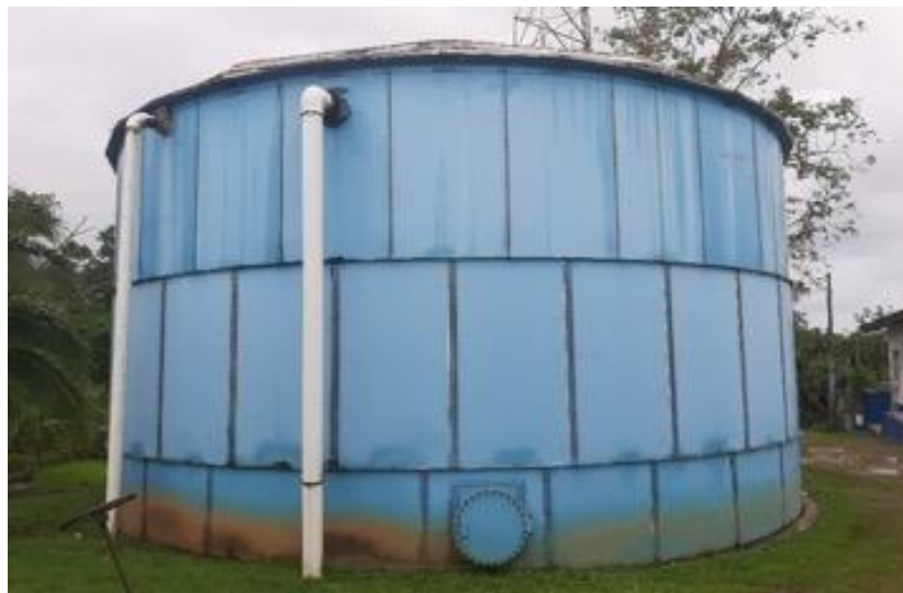
Ilustración 7. Tanque de reserva de 200,000 galones.
