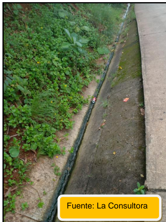
Ilustración 38 Otra vista de la cuneta que transporta aguas negras hasta la quebrada en caída que se encuentra más abajo.
