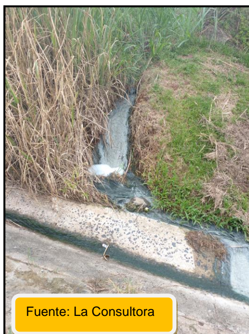
Ilustración 39 Aquí se observa las aguas negras provenientes de los tanques sépticos que ya colapsaron de la barriada originando insalubridad y malos olores a la comunidad.
