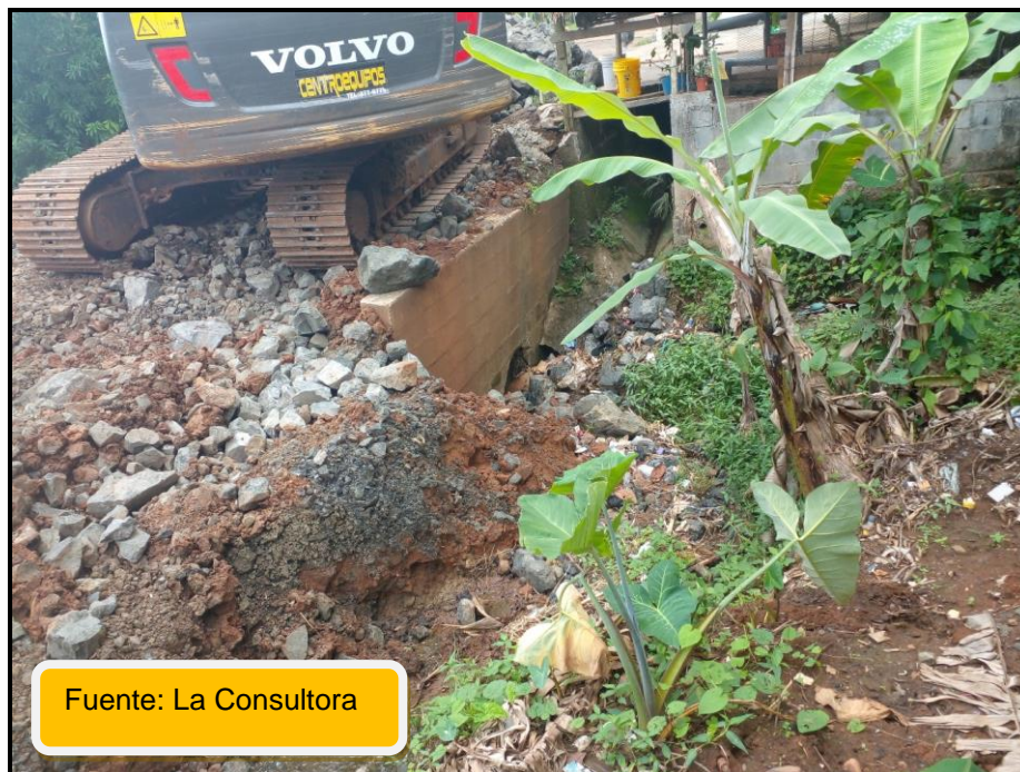
Ilustración 33 Aquí se observa la canalización que se está trabajando para mejorar la calle de acceso que lleva al proyecto, ya que la quebrada pasa por debajo de la calle.
