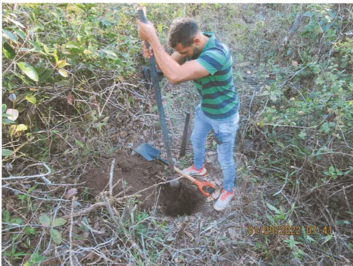
Fig. 14. Excavación del PS 41.
