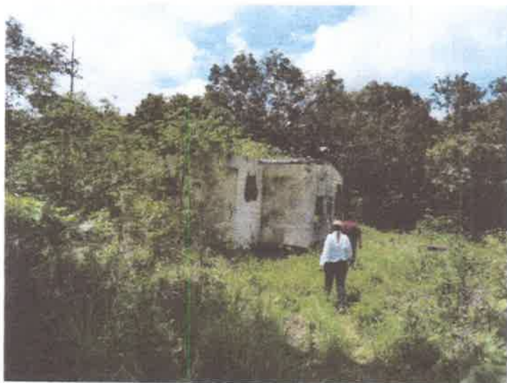
Foto 1. Construcciones en abandono dentro de la propiedad a desarrollar.
