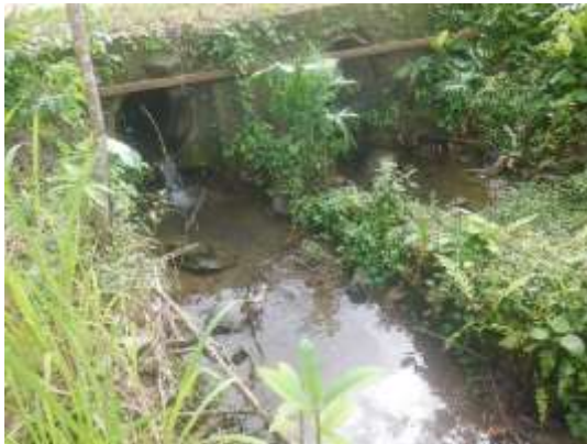
Foto N° 13: Vista general. Tramo prospectado Anegado.
