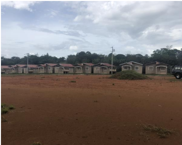
VISTA DEL SECTOR NORTE DEL POLIGONO
