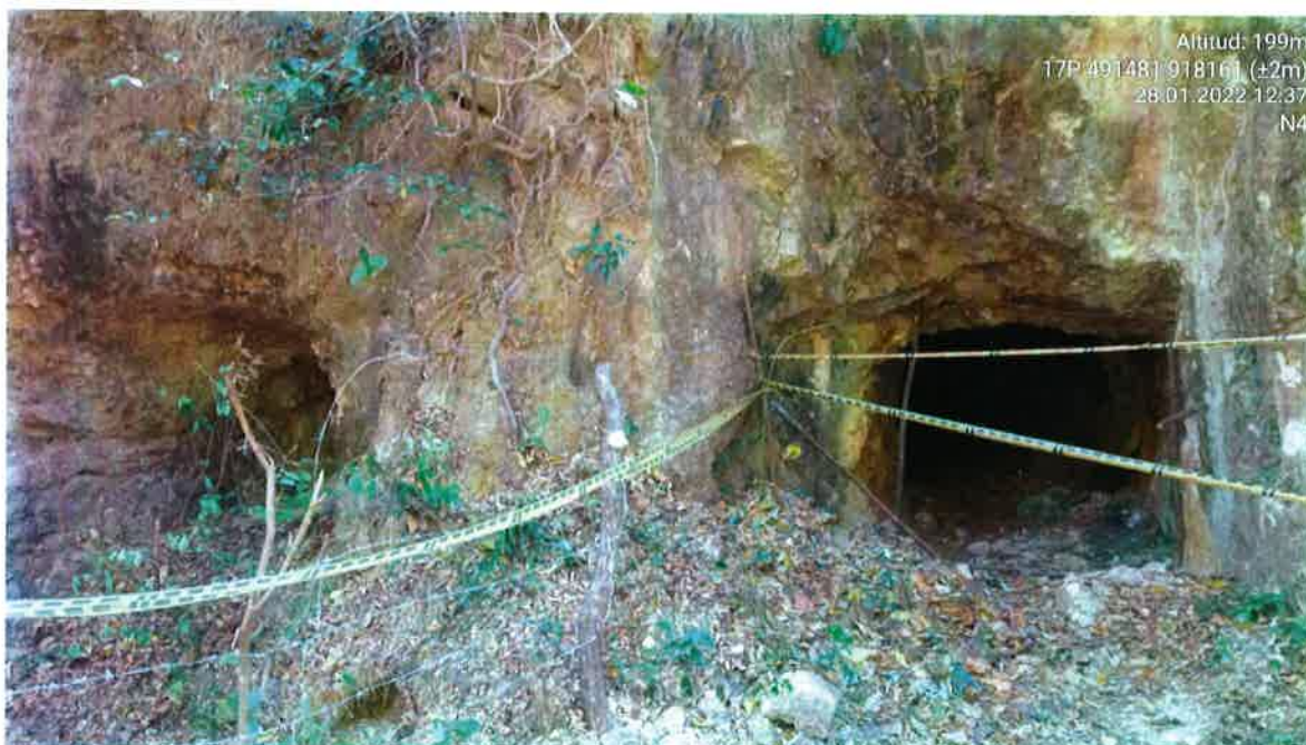
Foto N°5. El túnel Nivel #4 cuenta con dos (2) entradas, se observan bloques caídos del techo y pared lateral.
