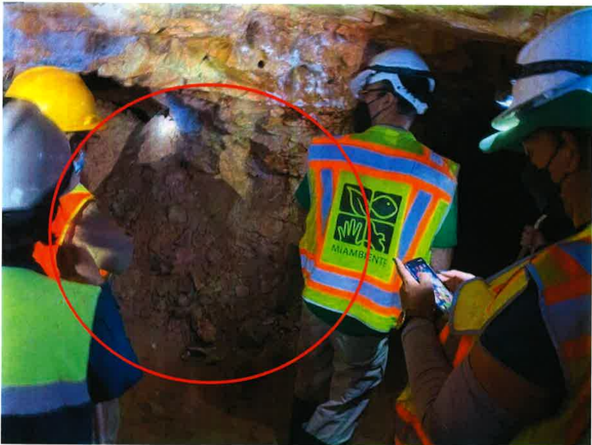
Foto N°13. Pequeños bloques de roca colapsados dentro del túnel Nivel #3 del Cerro Principal.
