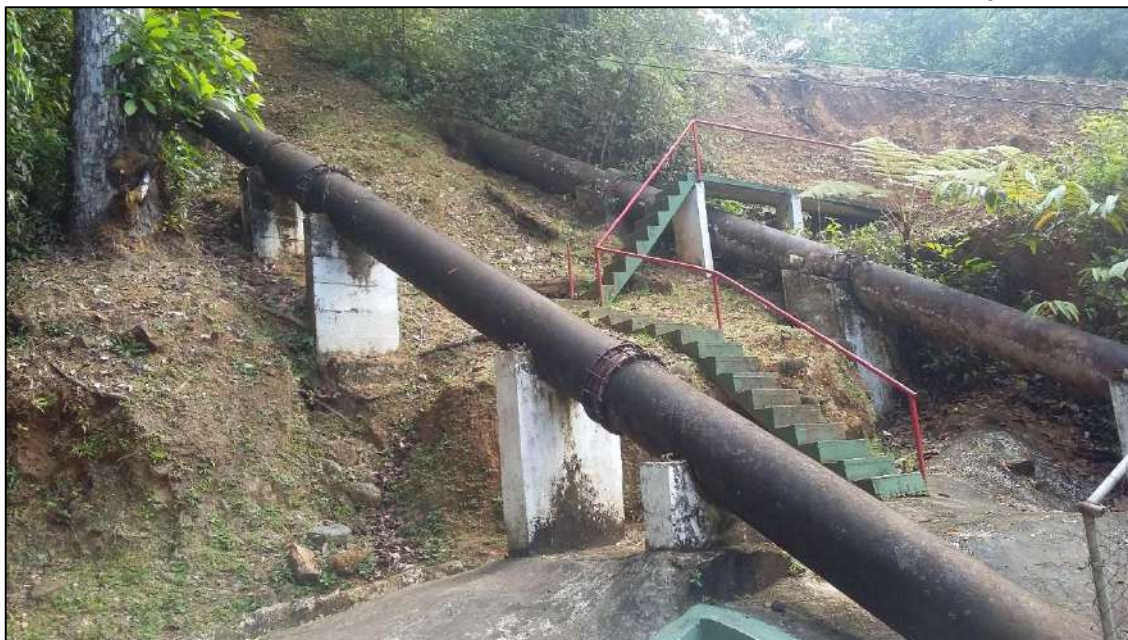
Foto No. 16. Línea de conducción del agua hacia la casa de máquinas.
