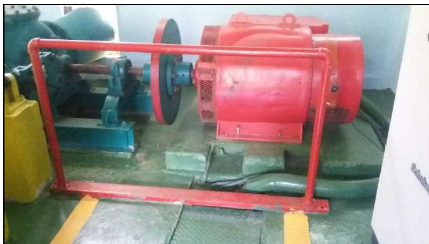
Foto No. 3. Barra de Seguridad para la protección de los colaboradores para la prevención de accidentes
