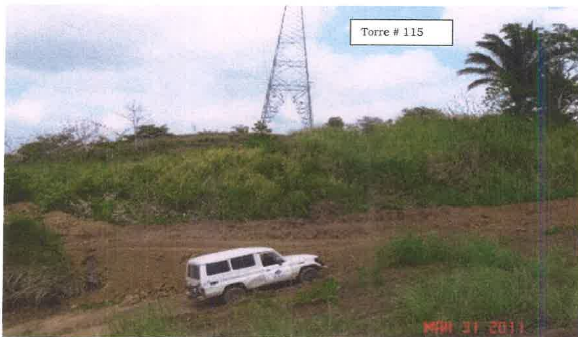
Fotografía 1: Imagen tomada en marzo 2011 en donde se observa movimiento de tierra debajo de la Línea de Transmisión, actividad que no puede realizarse dentro de la servidumbre eléctrica.
