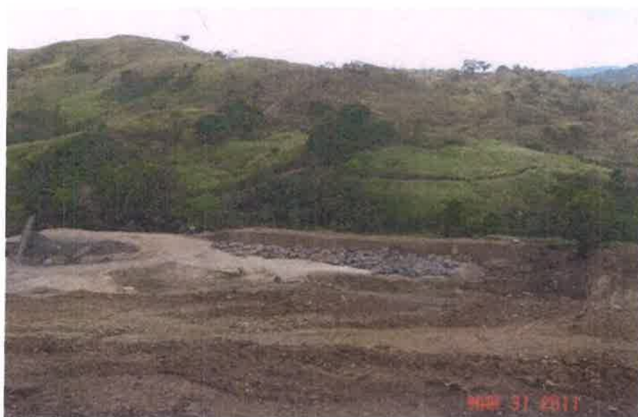
Fotografía 3 Imagen tomada en marzo 2011 se observa la realización de actividades de acumulación de material rocosa, cambio en topografía debajo de la servidumbre eléctrica. Actividad no permitida por seguridad de la línea de transmisión.
