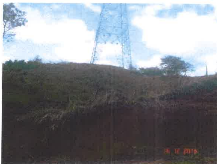
Fotografía 3 Imagen tomada en diciembre 2014 se observa la cercanía de las actividades dadas a la Torre 115, situación que pone en peligro la estabilidad de la torre.
