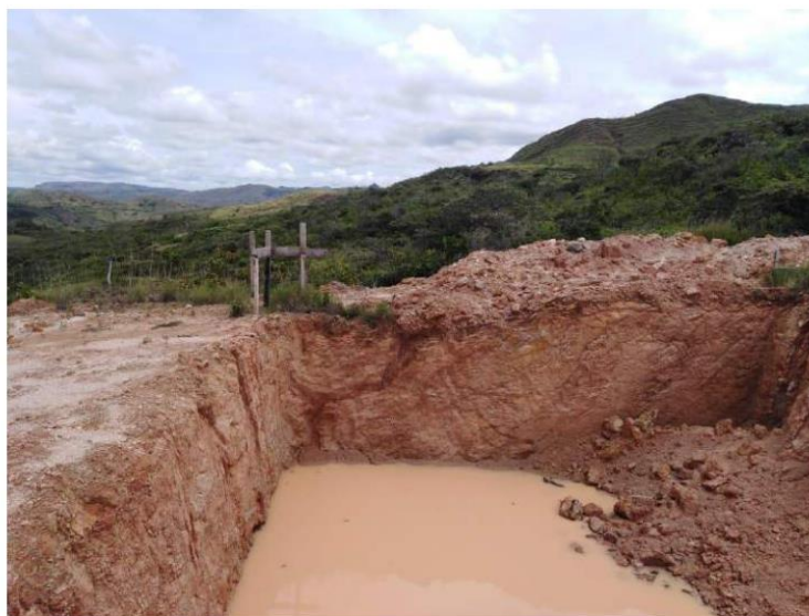
Figura No. 9 | Excavación abierta donde se aprecia la matriz rocosa del material de cimentación.
