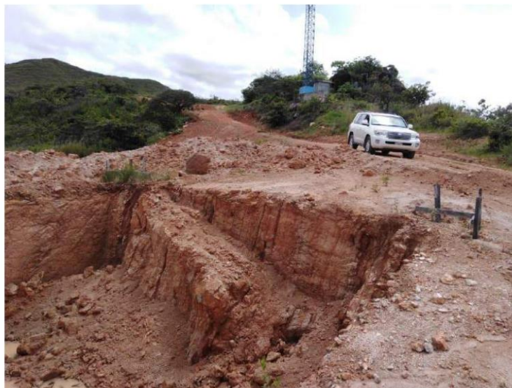
Figura No. 7 | Excavación para cimentación de torre eólica utilizada para toma de muestra
