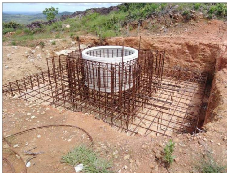
Figura No. 4 | Sistema de fundación típica para las torres eólicas en construcción.
