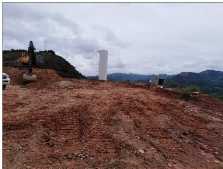
Figura No. 6 | Vista de torre erguida parcialmente en el cerro norte con fundaciones en construcción
