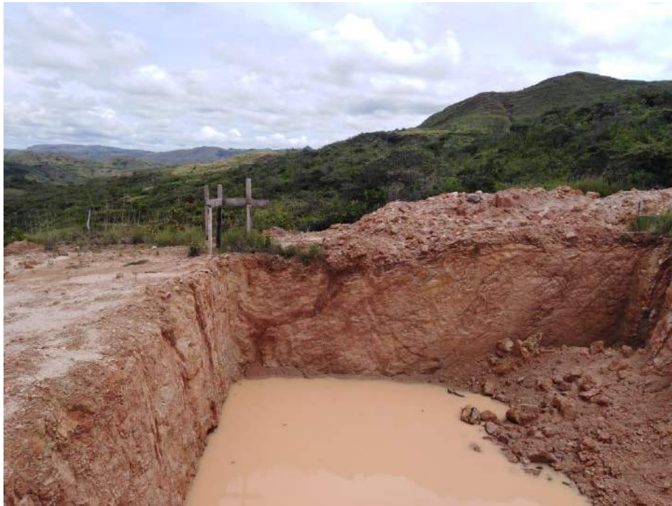
Figura No. 9 | Excavación abierta donde se aprecia la matriz rocosa del material de cimentación.
