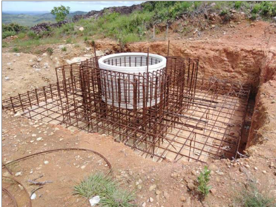
Figura No. 4 | Sistema de fundación típica para las torres eólicas en construcción.
