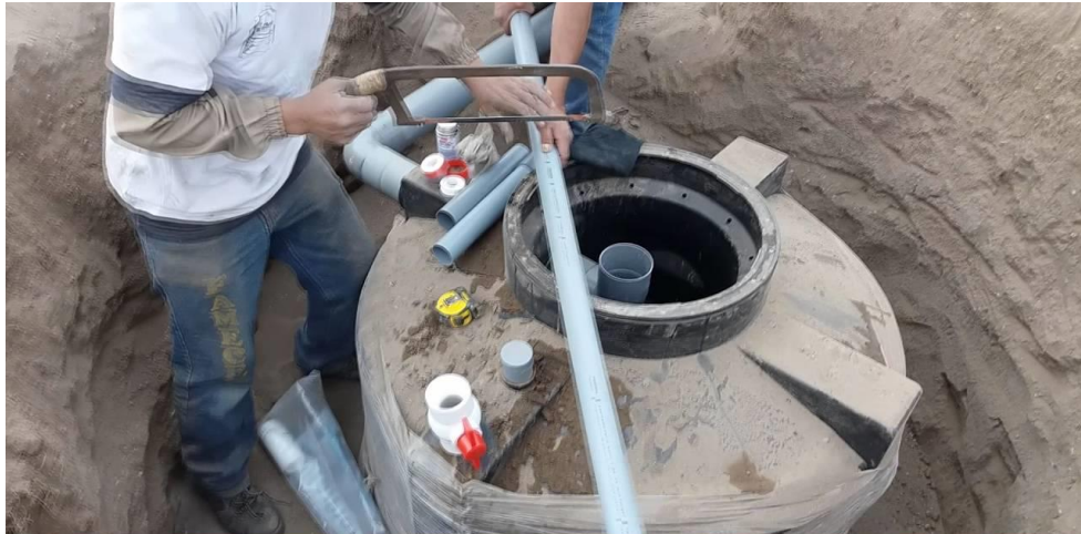
Figura 5.21 Instalación de biodigestor de polietileno.
