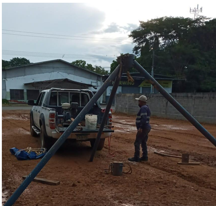
Figura 6.3. Sondeos realizados en el área del proyecto para pruebas de capacidad de soporte (SPT).
