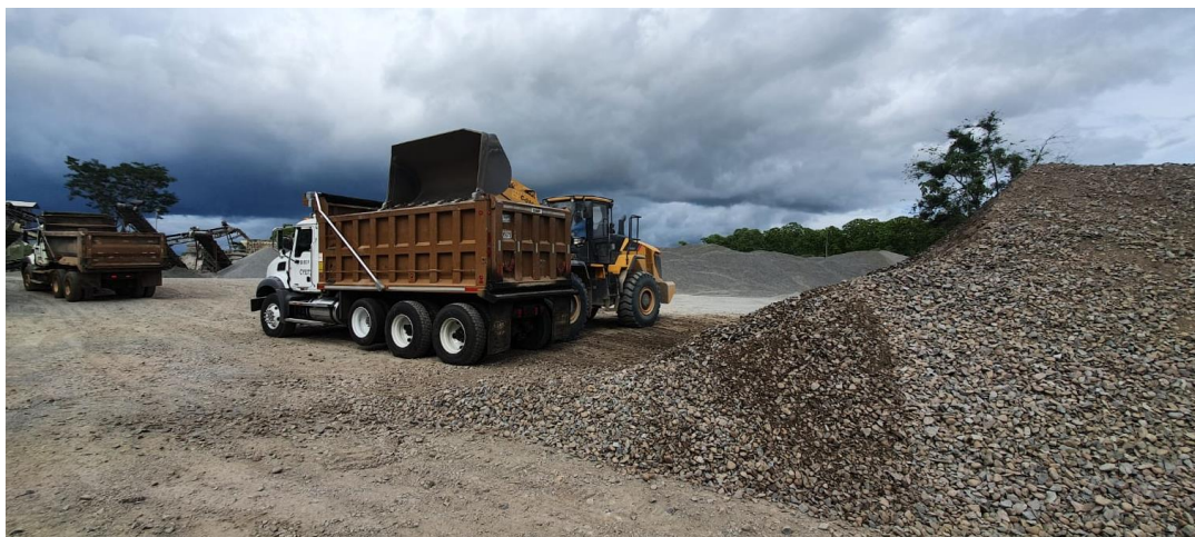
Foto Pila y carga de capa base.
