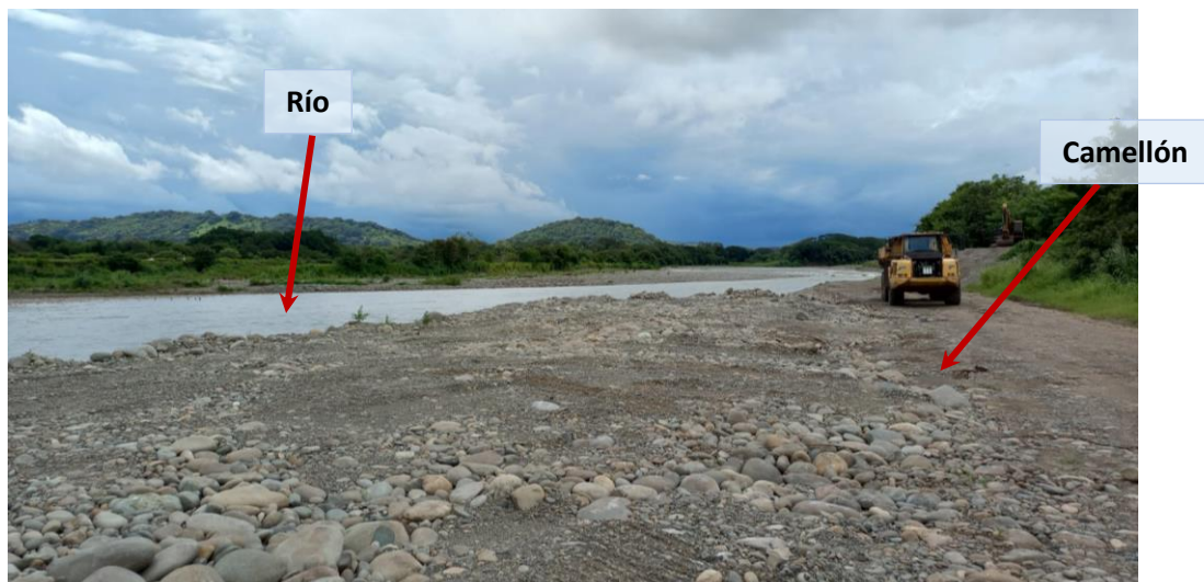
Foto. Ejemplo de camellón construido para extracción.
