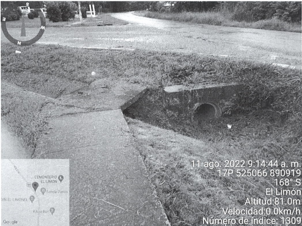
Fig. No. 6: Conexión del sistema de cunetas pluviales, en la servidumbre vial, próxima al área del proyecto.
