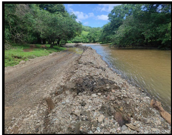
Camellón o ataguía de tránsito
