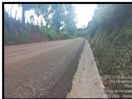
Capa base colocada en la calzada
