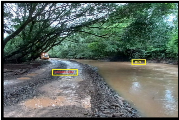
Camellón o ataguía de tránsito
