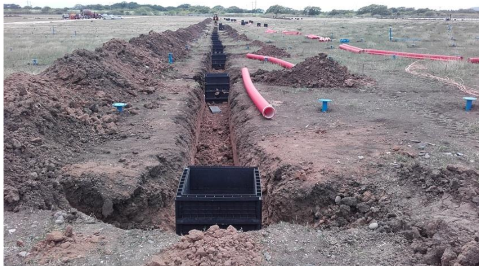
Figura 6. Ejemplo de zanjas para cables y cajas de registro.
