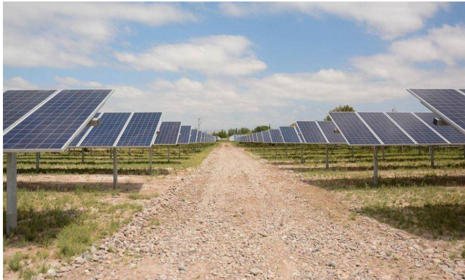
Figura 7. Ejemplo de instalación de paneles y caminos de servicio.
