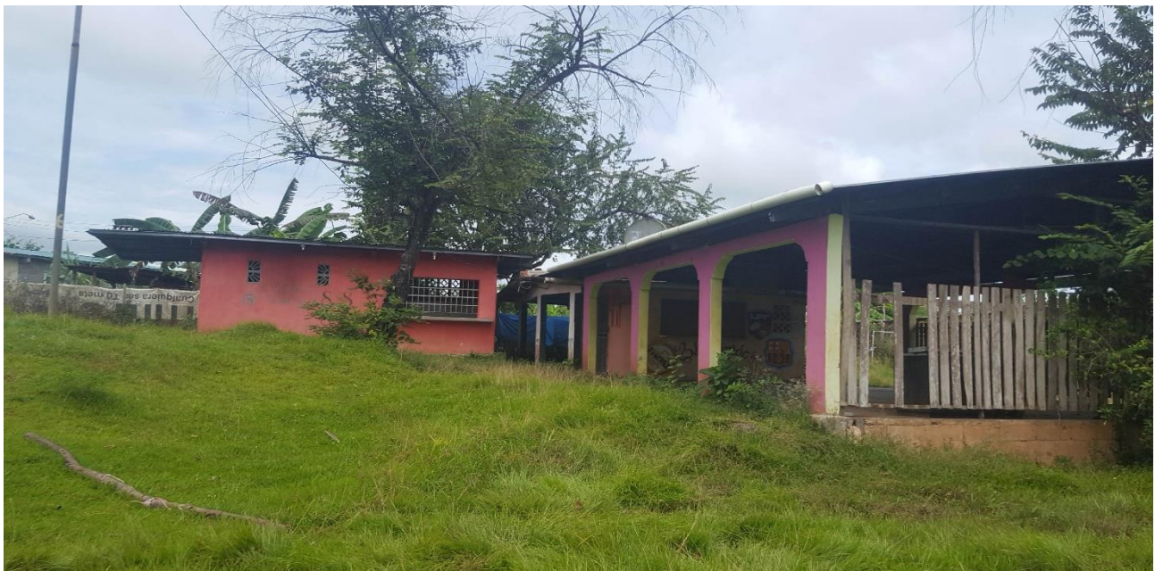
Foto N° 4. Vista de la estructura actual que existe en el lote, la misma será demolida. Los desechos (caliche) serán utilizados para relleno o depositados en sitio autorizado que puede ser el vertedero más cercano, el zinc y demás materiales serán utilizados para la caseta o deposito temporal.
