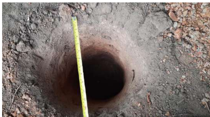
Figura 12 -Ejecución de ensayo de percolación 1
