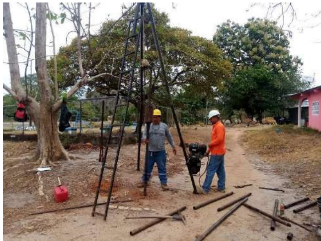
Figura 6 – Ejecución de ensayos SPT's
