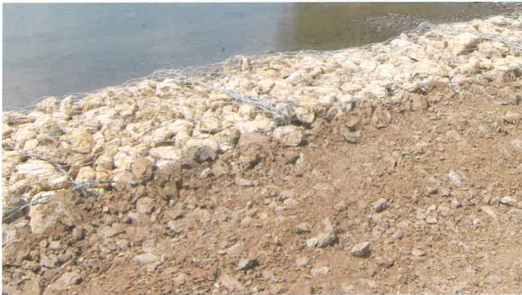
Foto N°6: Trabajos con gaviones realizados por la empresa en el rivera del cauce de la Quebrada Los Ranchos.
