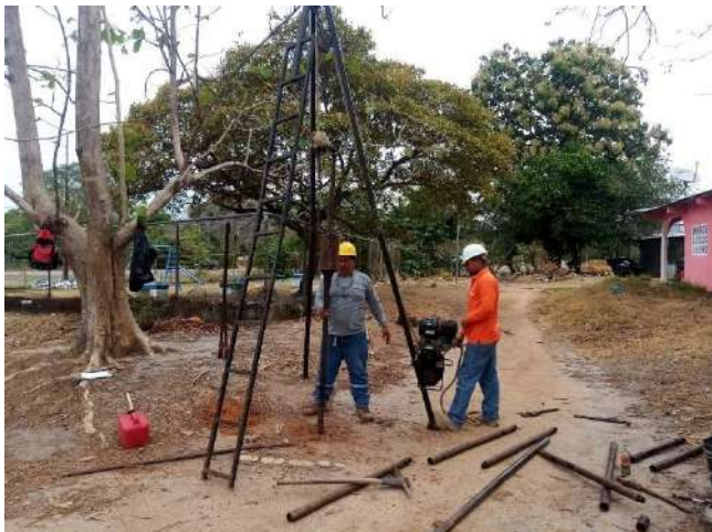
Figura 6 – Ejecución de ensayos SPT's
