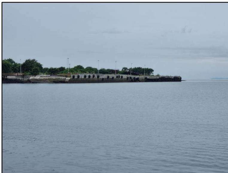
Ilustración 11. Muelle de Gaviones existente.
