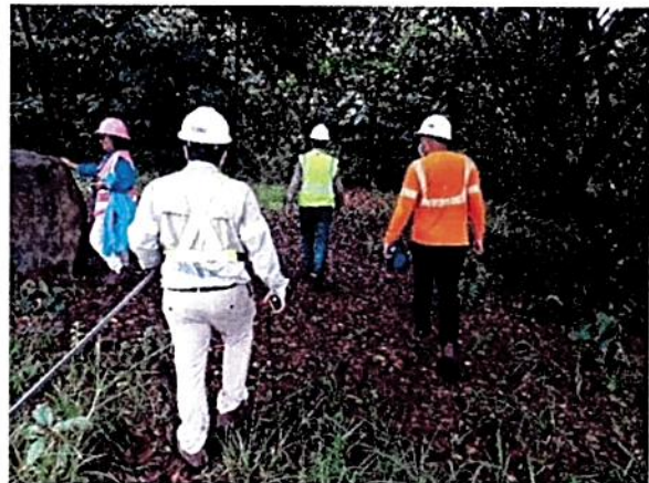
Figura 10: Trabajo en campo.
