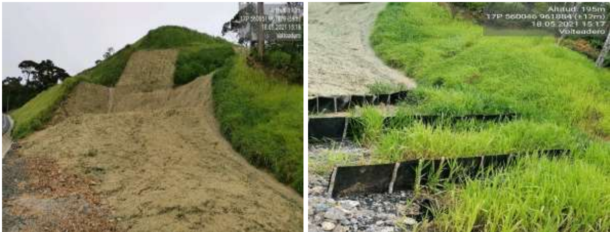
Imágenes 176 y 177. Trabajos de estabilización y controles de erosión en taludes de Volteadero (961879 N/ 560051 E; 961884 N/ 560046 E)
