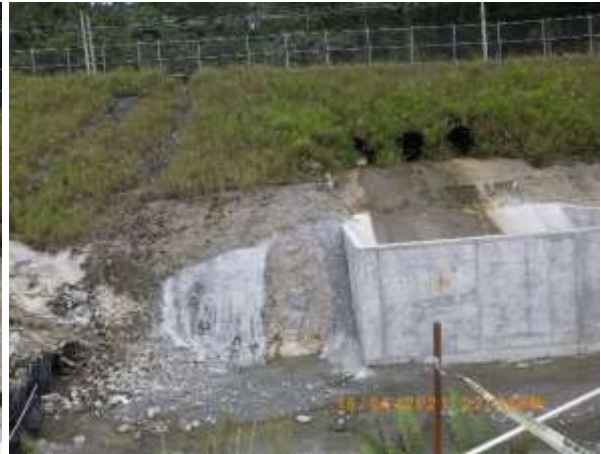
Imágenes 27 y 28. Cajón pluvial para manejo de escorrentías provenientes de la vía hacia la Planta de Procesos (977847 N/ 540431 E)
