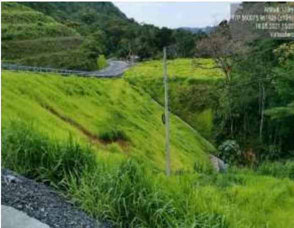
Imágenes 269 y 270. Falla en talud y cárcava con erosión en Torre de Decantación del TMF y Poza de Sedimentación 2 (982078 N/ 534962 E; 975343 N/ 537906 E)
