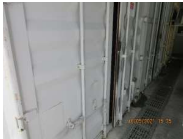
Imágenes 87 a 89. Pérdida de temperatura, condensación y mal estado exterior e interior en los cuartos fríos y en el cuarto de productos congelados del Campamento El Dorado (975147 N/ 537920 E)
