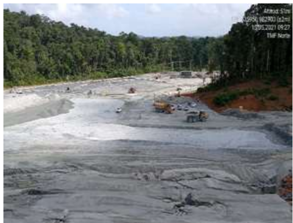
Imágenes 13 y 14. Vistas de la conformación de celdas de arena y material filtrante en el talud externo en el área de la Presa Norte de la IMR (982900 N/ 535948 E; 982903 N/ 535950 E)
