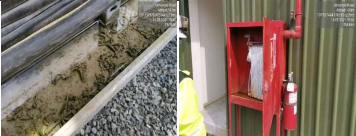
Imágenes 114 y 115. Agua estancada en riel de equipo y en el gabinete de manguera contra incendio en PM Bay (978344 N/ 537578 E; 978335 N/ 537484 E)
