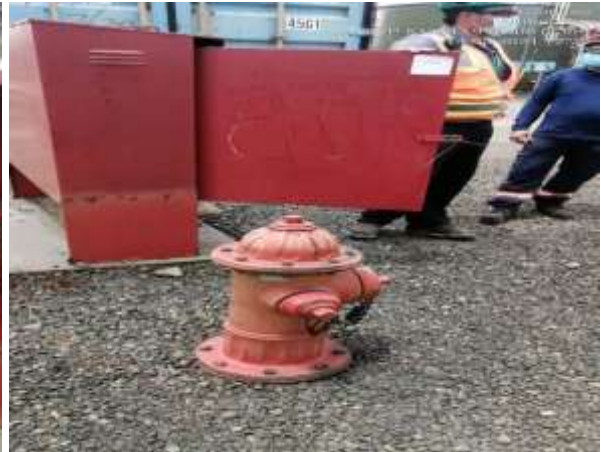
Imágenes 255 y 256. Ausencia de llave de paso de hidrante en el área de Almacén de Concentrado de Cobre (996406 N/ 532443 E)
