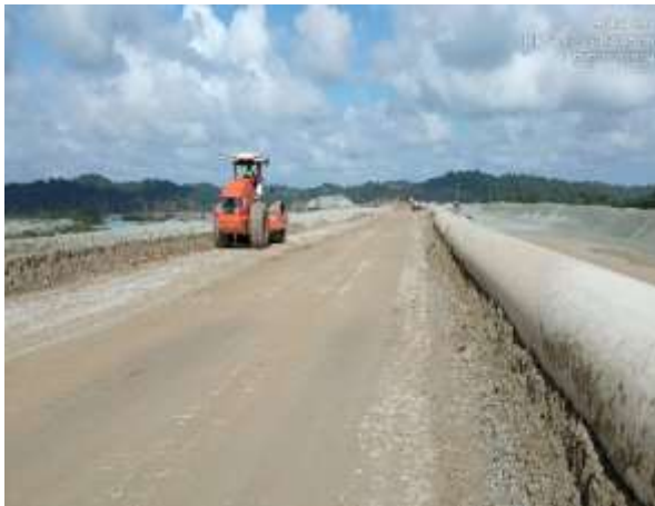
Imágenes 11 y 12. Recrecimiento y conformación de capa de saprolita en la Presa Norte de la IMR (983160 N/ 537471 E; 983114 N/ 537266 E)
