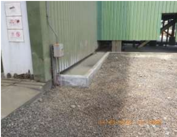
Imágenes 9 y 10. Contención secundaria en el sitio de transferencia del concentrado, Área de Almacenamiento de Concentrado de Cobre en Puerto (996450 N/ 533839 E)
