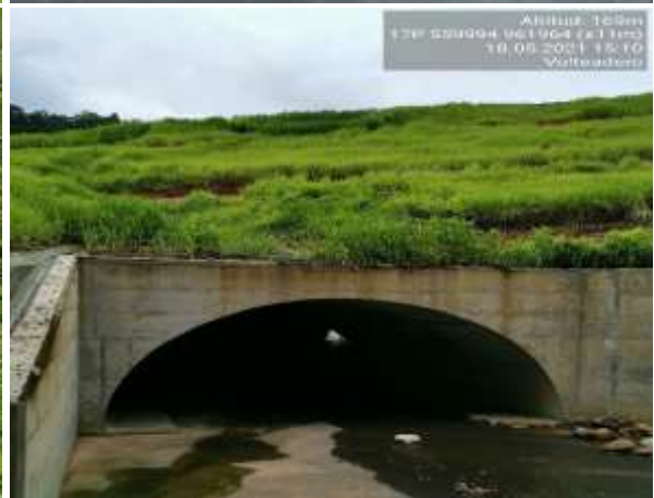
Imágenes 271 a 274. Revegetación mediante hidrosiembra en el área del realineamiento de la vía Volteadero, Cascajal (961926 N/ 560049 E; 961856 N/ 560049 E; 962062 N/ 559997 E; 961964 N/ 559994 E)
