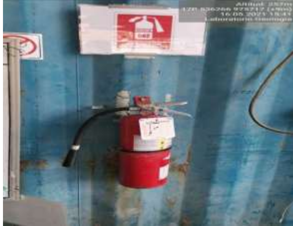
Imagen 249. Extintor vencido y la señalización no coincide con el tipo de extintor (975717 N/ 536266 E)
