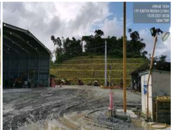
Imágenes 67 a 70. Rehabilitación de áreas en el Botadero Botija, Tajo Botija y Taller TMF, mediante hidrosiembra y construcción de drenes cubiertos con geomembrana (976411 N/ 537709 E; 978201 N/ 536931 E; 983064 N/ 538745 E)
