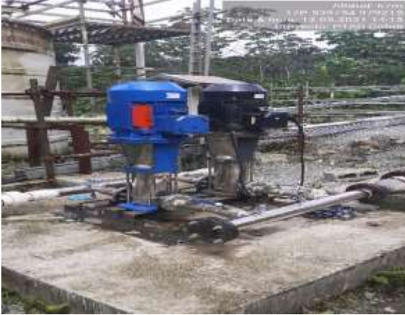
Imágenes 49 y 50. Sistema de bombeo de las aguas tratadas en la PTAR del Campamento Cobre hacia la Planta de Procesos, para su reutilización (979215 N/ 539754 E)
