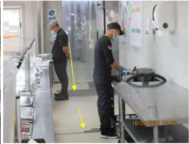
Imágenes 81 y 82. Desgaste general del piso de la cocina y mal estado del linóleo en el área de despacho de los alimentos del Campamento El Dorado (975147 N/ 537920 E)
