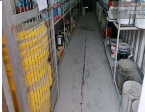
Imagen 216. Presencia de kit de control de derrames y contención secundaria en el depósito de sustancias del Taller Eléctrico (978513 N/ 539031 E)
