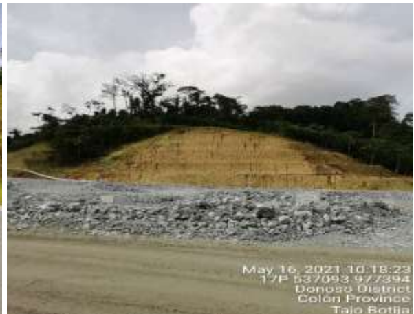
Imágenes 266 y 267. Taludes con bermas y revegetación en Tajo Botija (977394 N/ 537093 E; 976474 N/ 537603 E)
