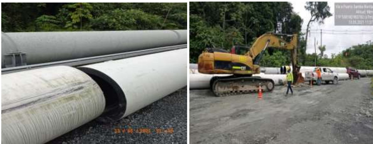
Imágenes 1 y 2. Trabajos de construcción de nueva línea de tuberías para manejo de agua hacia la Planta de Ciclones (983762 N/ 538203 E)
