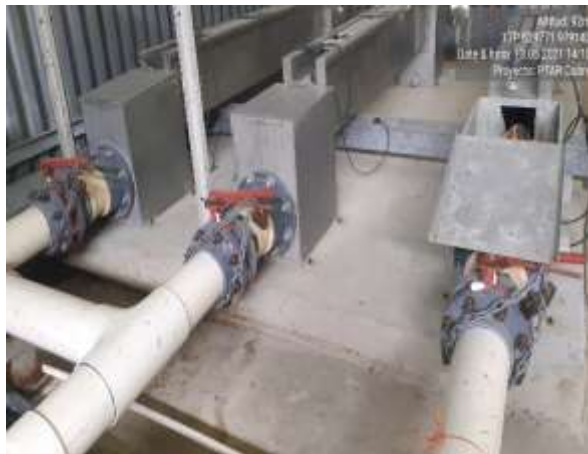
Imagen 48. Válvulas de la PTAR del Campamento Cobre, cerradas y con candado (979143 N/ 539771 E)
