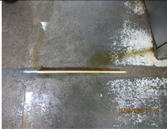
Imagen 83. Fuga de aceite residual en el horno principal de la cocina del Campamento El Dorado (comida caliente), 975147 N/ 537920 E
