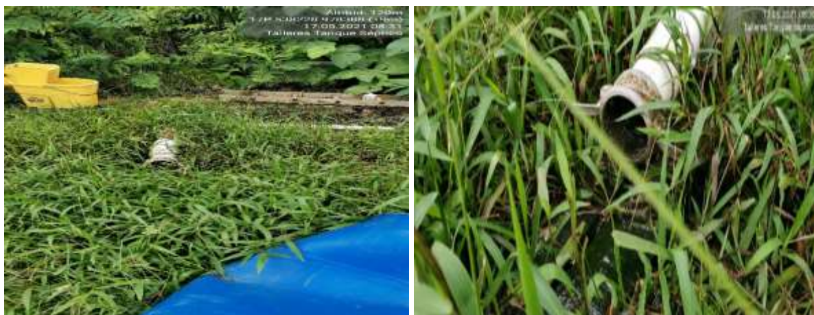
Imágenes 282 y 283. Desborde de aguas negras provenientes de un tanque séptico del Taller de Mecánica en Sitio Mina (978388 N/ 538228 E)
