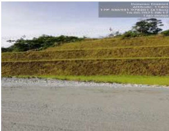
Imágenes 266 y 267. Taludes con bermas y revegetación en Tajo Botija (977394 N/ 537093 E; 976474 N/ 537603 E)
