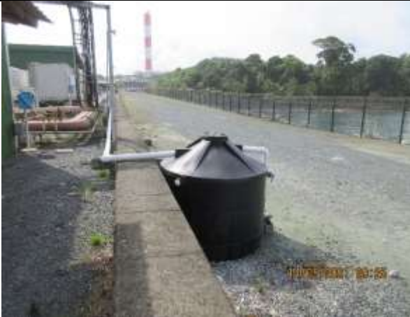
Imágenes 284 y 285. Tanque séptico con fuga de aguas negras en el área de la Terminal 1 en Puerto (997040 N/ 533382 E)
