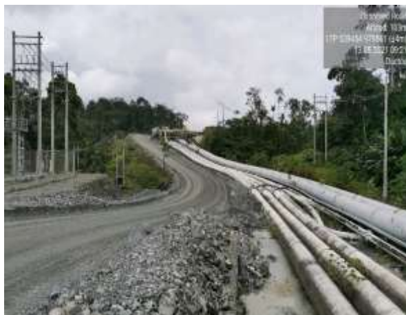
Imagen 257. Poca visualización de rotulado e identificación en los ductos del Camino a la Costa (979561 N/ 539454 E)
