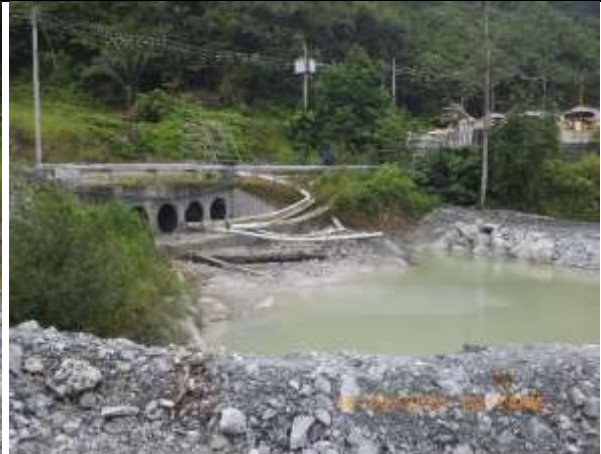
Imágenes 29 y 30. Adecuaciones en el área de la Poza de Sedimentación 20, para manejo de las escorrentías en el área (977419 N/ 540171 E)
