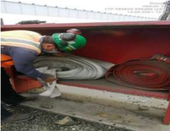
Imágenes 255 y 256. Ausencia de llave de paso de hidrante en el área de Almacén de Concentrado de Cobre (996406 N/ 532443 E)
