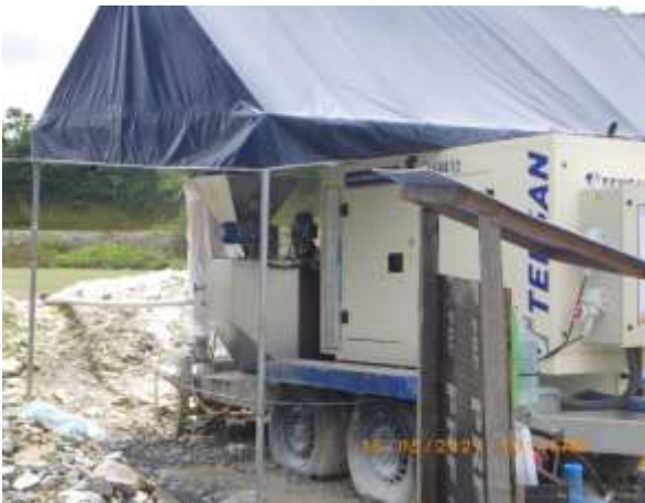
Imágenes 35 y 36. Unidad de dosificación de cal en la Poza de Sedimentación 2 para el control del pH del agua (976358 N/ 537943 E)
