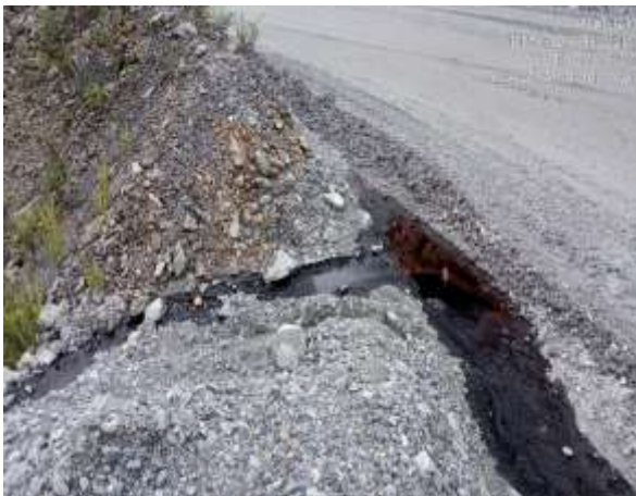
Imágenes 209 y 210. Derrame de aceite proveniente de mezcla asfáltica, en Rotonda MSA (978913 N/ 539321 E)
