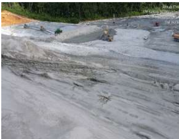
Imágenes 13 y 14. Vistas de la conformación de celdas de arena y material filtrante en el talud externo en el área de la Presa Norte de la IMR (982900 N/ 535948 E; 982903 N/ 535950 E)
