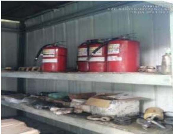
Imágenes 247 y 248. Extintores en el área del depósito y obstruidos en el área del Taller Presa Norte (982760 N/ 536076 E)
