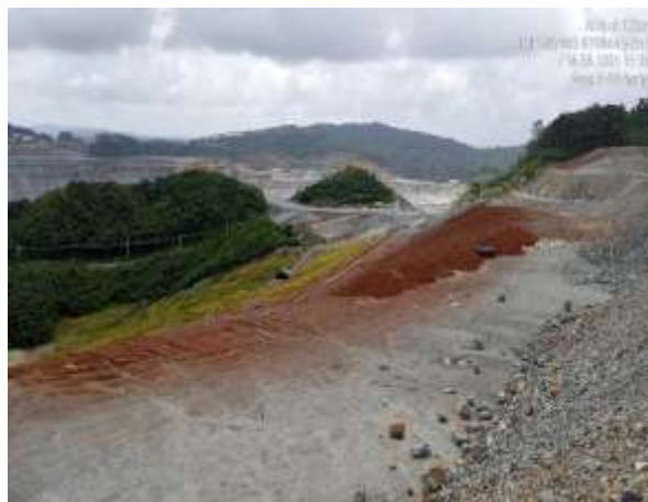
Imágenes 20 y 21. Conformación de celda de saprolita en Botadero Sur del Tajo Botija (975828 N/ 538055 E; 975844 N/ 537941 E)
