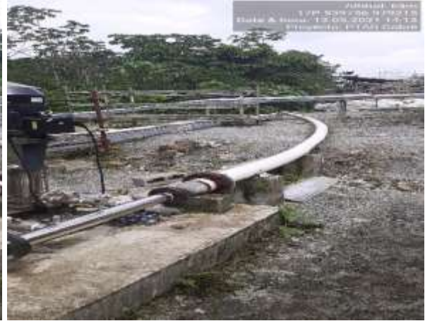
Imágenes 49 y 50. Sistema de bombeo de las aguas tratadas en la PTAR del Campamento Cobre hacia la Planta de Procesos, para su reutilización (979215 N/ 539754 E)
