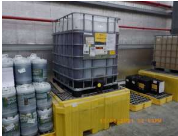
Imágenes 229 a 232. Sistemas de contención secundaria para las sustancias del Almacén MSA (978508 N/ 537176 E)
