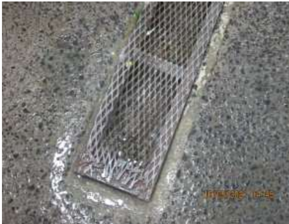
Imágenes 84 y 85. Parrillas del desagüe en mal estado y piso con agua estancada en el área de limpieza de los utensilios de cocina (Fregador) del Campamento El Dorado, 975147 N/537920 E
