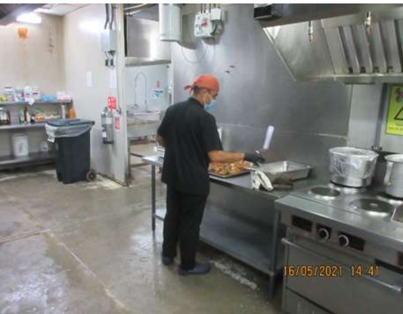
Imágenes 81 y 82. Desgaste general del piso de la cocina y mal estado del linóleo en el área de despacho de los alimentos del Campamento El Dorado (975147 N/ 537920 E)
