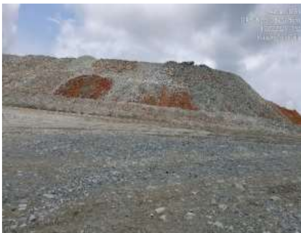
Imágenes 20 y 21. Conformación de celda de saprolita en Botadero Sur del Tajo Botija (975828 N/ 538055 E; 975844 N/ 537941 E)
