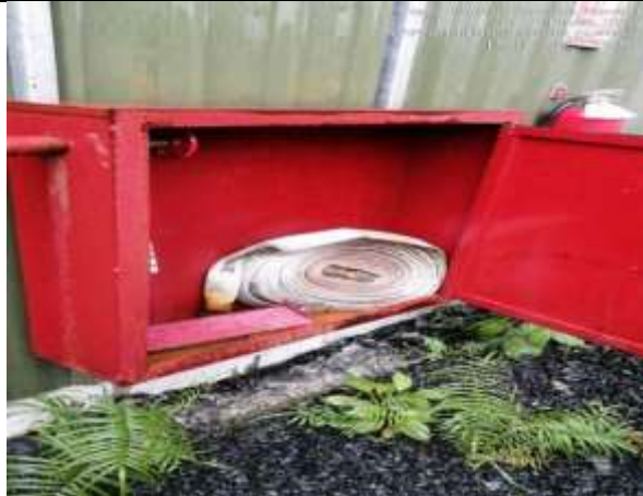
Imagen 246. Red húmeda contra incendio sin serpentina en la Planta de Emulsión de Amonio (980932 N/ 539435 E)
