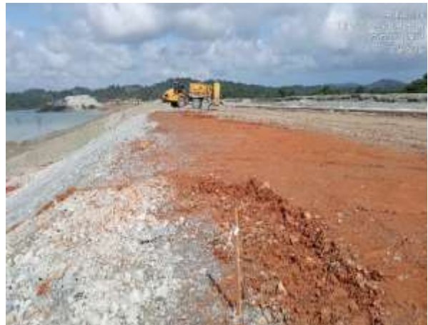
Imágenes 11 y 12. Recrecimiento y conformación de capa de saprolita en la Presa Norte de la IMR (983160 N/ 537471 E; 983114 N/ 537266 E)
