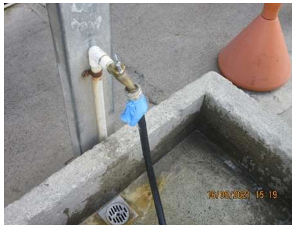
Imagen 91. Manguera en mal estado y con fugas en la parte externa del comedor del Campamento El Dorado (975147 N/ 537920 E)
