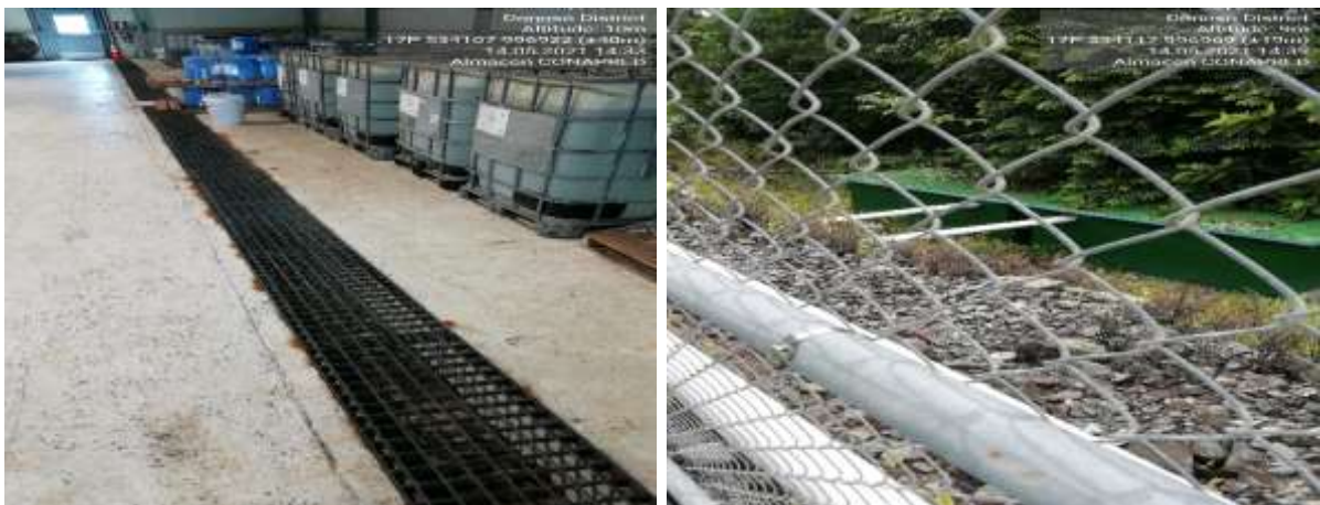
Imágenes 206 y 207. Canales de drenaje y contenedor para recolección de derrames en el Almacén de Reactivos en Puerto (996922 N/ 534107 E; 996969 N/ 534117 E)
