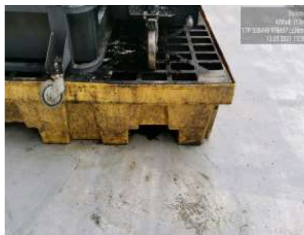
Imagen 228. Fuga de aceite de un sistema secundario de contención de derrame en el Taller Táctico (978657 N/ 538498 E)
