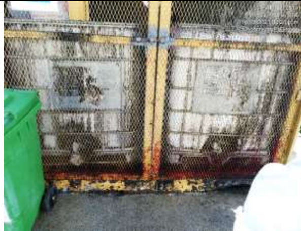
Imagen 86. Ausencia de tina de contención en el área de depósito de aceite vegetal usado en el Campamento El Dorado (975147 N/ 537920 E)
