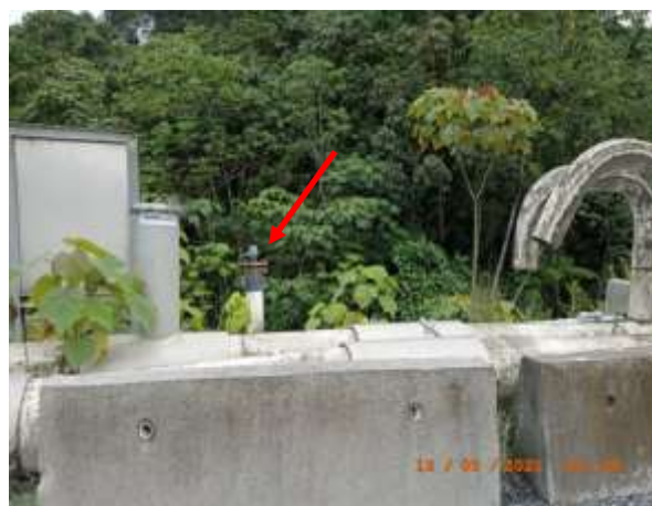
Imagen 258. Punto de medición de presión conectado a fibra en los ductos paralelos al Camino a la Costa (979562 N/ 539451 E)
