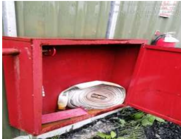
Imagen 116. Agua estancada en gabinete de manguera contra incendio en la Planta de Emulsiones (980932 N/ 539435 E)
