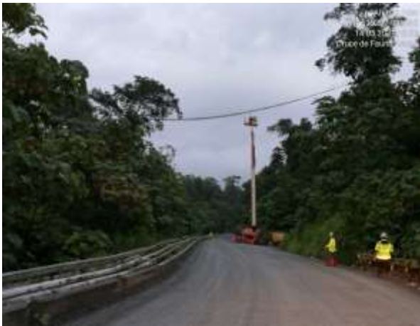
Imágenes 55 y 56. Instalación de puente colgante para el cruce de fauna en el Camino a la Costa (986985 N/ 535237 E)
