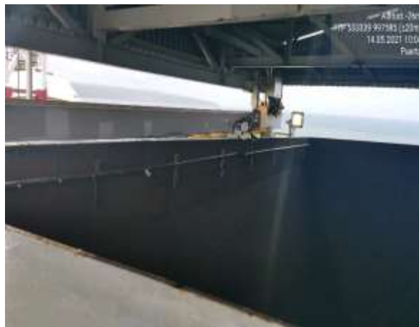
Imágenes 5 y 6. Rociadores para control de polvo del carbón en la Terminal 2 de Punta Rincón (997585 N/ 533339 E)
