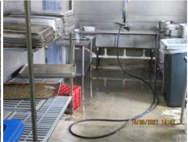
Imágenes 84 y 85. Parrillas del desagüe en mal estado y piso con agua estancada en el área de limpieza de los utensilios de cocina (Fregador) del Campamento El Dorado, 975147 N/537920 E
