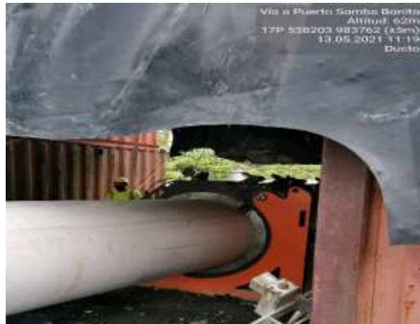
Imagen 175. Trabajos de termofusión entre dos contenedores que funcionan como barrera física de ruido, en los ductos del Camino a la Costa (983762 N/ 538203 E)
