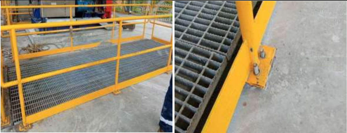
Imágenes 163 y 164. Estructura en el área de la Torre de Decantación, sin tuercas y desajuste en la base del pasamanos (982078 N/ 534961 E)
