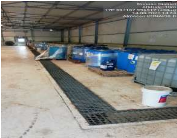
Imágenes 201 y 202. Disposición de las sustancias según compatibilidad y señalizaciones del tipo de sustancias agrupadas en el Almacén de Reactivos en Puerto (996917 N/ 534107 E; 996921 N/ 534103 E)
