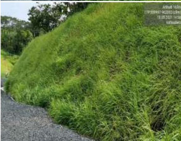
Imágenes 271 a 274. Revegetación mediante hidrosiembra en el área del realineamiento de la vía Volteadero, Cascajal (961926 N/ 560049 E; 961856 N/ 560049 E; 962062 N/ 559997 E; 961964 N/ 559994 E)
