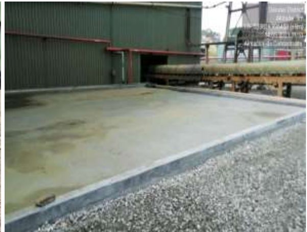
Imágenes 9 y 10. Contención secundaria en el sitio de transferencia del concentrado, Área de Almacenamiento de Concentrado de Cobre en Puerto (996450 N/ 533839 E)
