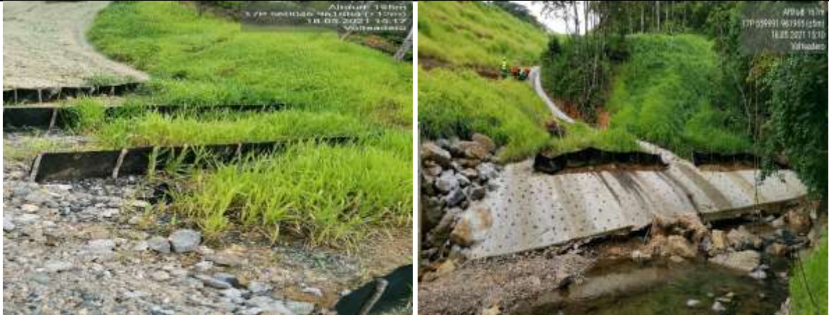
Imágenes 278 y 279. Barreras de sedimentos (silt fence) implementados en las áreas de la carretera de Volteadero, Cascajal (961884 N/ 560046 E; 961965 N/ 559991 E)
