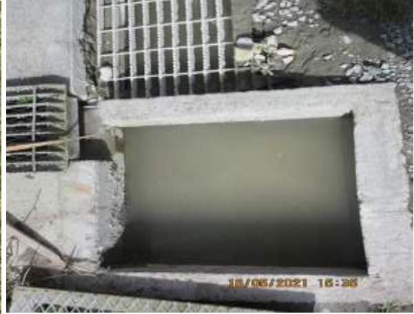
Imágenes 92 y 93 Agua estancada al lado de la trampa de grasa de la cocina del Campamento El Dorado y obstrucción del desagüe (975147 N/ 537920 E)
