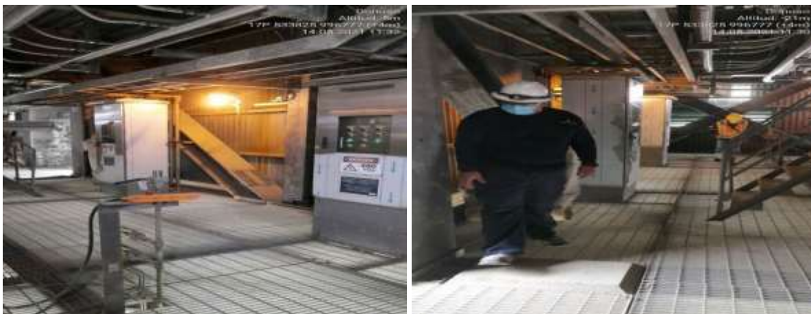
Imágenes 243 y 244. Ausencia de extintor en el Cuarto de Bombeo de Cenizas (996777 N/ 533825 E)
