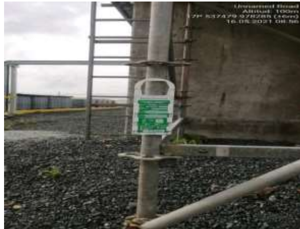
Imagen 143. Andamio sin libranza, solo mantiene la etiqueta de inspección en el área PM Bay (978285 N/ 537479 E)
