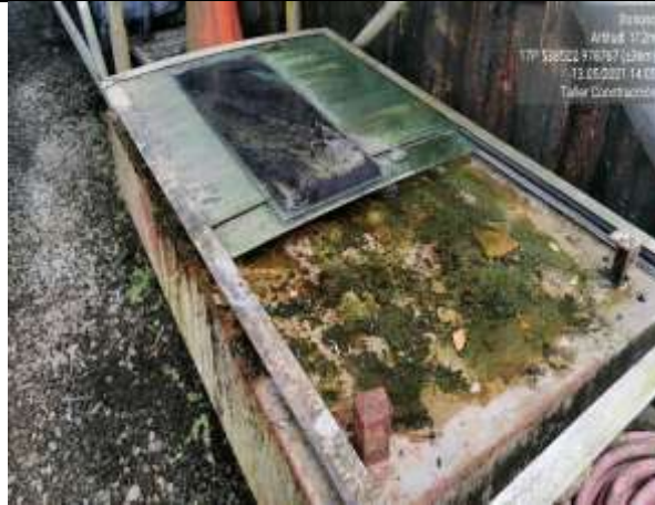
Imagen 109. Agua estancada sobre estructura metálica en el Taller de Construcción (978767 N/ 538522 E)
