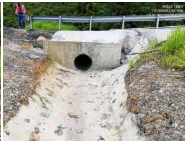
Imágenes 276 y 277. Drenajes de concreto para manejo de escorrentías implementados en la carretera de Volteadero, Cascajal (961902 N/ 560053 E; 961935 N/ 560093 E)
