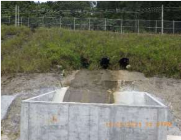
Imágenes 27 y 28. Cajón pluvial para manejo de escorrentías provenientes de la vía hacia la Planta de Procesos (977847 N/ 540431 E)
