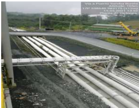
Imágenes 342 y 343. Líneas de entrada de la Planta de Ciclones (983175 N/ 538640 E)
