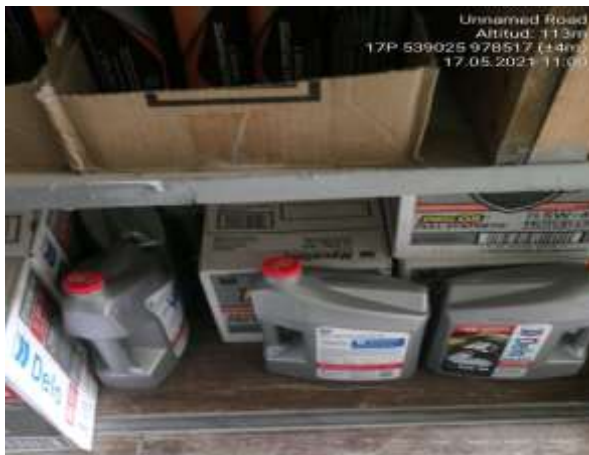
Imágenes 226 y 227. Ausencia de sistema de contención secundaria en el depósito de sustancias del Área 64 (978517 N/ 539025 E)
