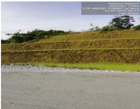
Imágenes 67 a 70. Rehabilitación de áreas en el Botadero Botija, Tajo Botija y Taller TMF, mediante hidrosiembra y construcción de drenes cubiertos con geomembrana (976411 N/ 537709 E; 978201 N/ 536931 E; 983064 N/ 538745 E)
