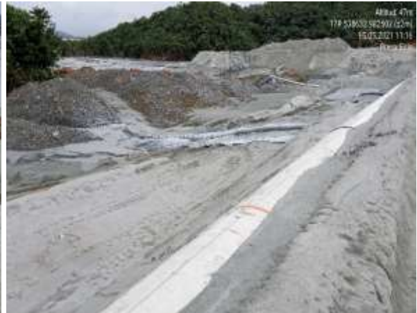
Imágenes 17 y 18. Disposición de relaves en el sector de la Presa Este de la IMR (985502 N/ 538632 E)
