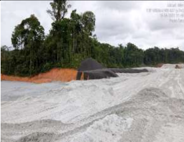
Imágenes 15 y 16. Recrecimiento con celdas de arena en la Presa Este de la IMR (981437 N/ 538664 E; 981454 N/ 538658 E)
