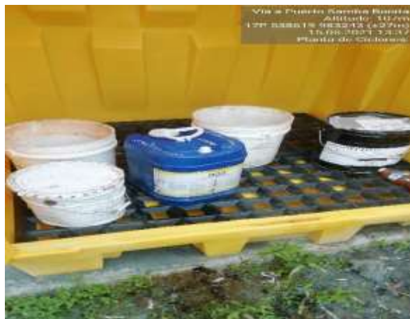
Imagen 233. Sistema de contención secundaria en la Planta de Ciclones del TMF (983243 N/ 538619 E)
