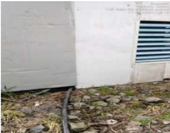
Imágenes 161 y 162. Panel eléctrico sobre zanja pluvial sin delimitación ni señalización en el área del Tajmahal, (978302 N/ 538122 E)
