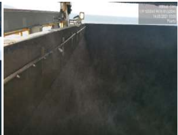
Imágenes 5 y 6. Rociadores para control de polvo del carbón en la Terminal 2 de Punta Rincón (997585 N/ 533339 E)
