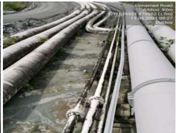
Imágenes 3 y 4 Contacto entre líneas de tuberías paralelas al Camino a la Costa (994016 N/ 533034 E; 979562 N/ 539451 E)
