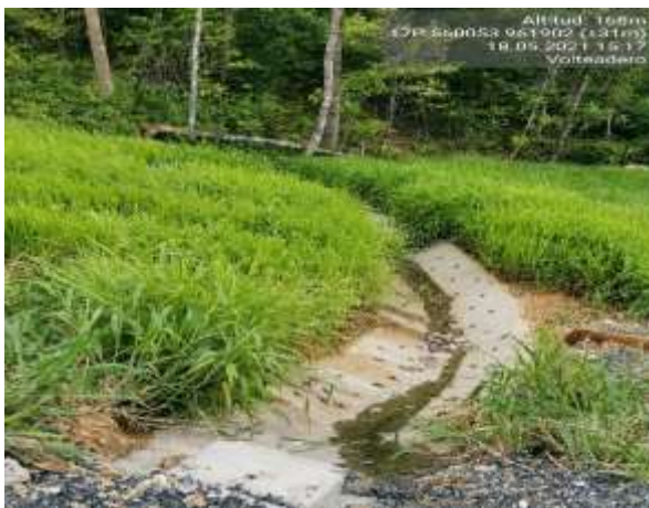
Imágenes 276 y 277. Drenajes de concreto para manejo de escorrentías implementados en la carretera de Volteadero, Cascajal (961902 N/ 560053 E; 961935 N/ 560093 E)
