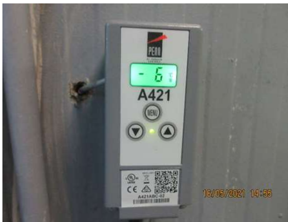
Imágenes 87 a 89. Pérdida de temperatura, condensación y mal estado exterior e interior en los cuartos fríos y en el cuarto de productos congelados del Campamento El Dorado (975147 N/ 537920 E)
