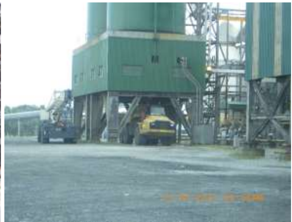
Imágenes 22 y 23. Camión recibiendo las cenizas en el silo de la Planta de Generación Eléctrica para su transporte al Área de Depósito de Cenizas (996929 N/ 533736 E)
