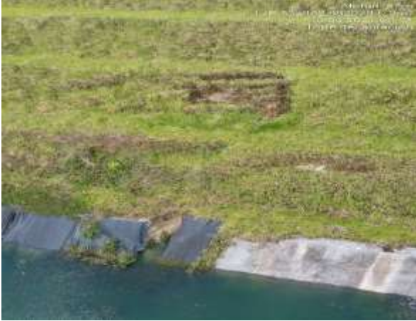
Imágenes 269 y 270. Falla en talud y cárcava con erosión en Torre de Decantación del TMF y Poza de Sedimentación 2 (982078 N/ 534962 E; 975343 N/ 537906 E)
