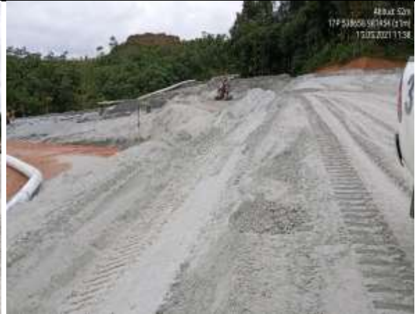
Imágenes 15 y 16. Recrecimiento con celdas de arena en la Presa Este de la IMR (981437 N/ 538664 E; 981454 N/ 538658 E)
