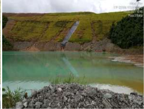
Imágenes 269 y 270. Falla en talud y cárcava con erosión en Torre de Decantación del TMF y Poza de Sedimentación 2 (982078 N/ 534962 E; 975343 N/ 537906 E)
