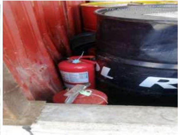
Imágenes 247 y 248. Extintores en el área del depósito y obstruidos en el área del Taller Presa Norte (982760 N/ 536076 E)
