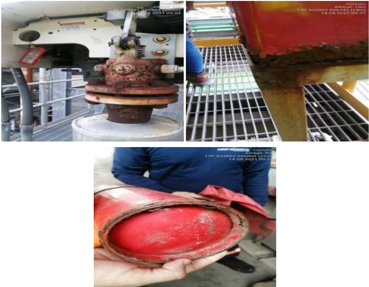
Imágenes 250 a 252. Equipos de protección contra incendios corroídos y deteriorados en la Planta de Generación Eléctrica (996809 N/ 533893 E)
