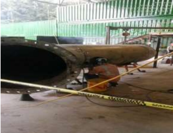
Imágenes 144 y 145. Trabajos de soldadura sin uso adecuado de extintor en el área Tajmahal (978365 N/ 538207 E)
