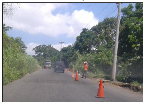
Señalizaciones y banderilleros para control de movimiento vehicular
