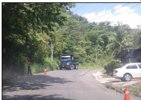
Señalizaciones y banderilleros para control de movimiento vehicular
