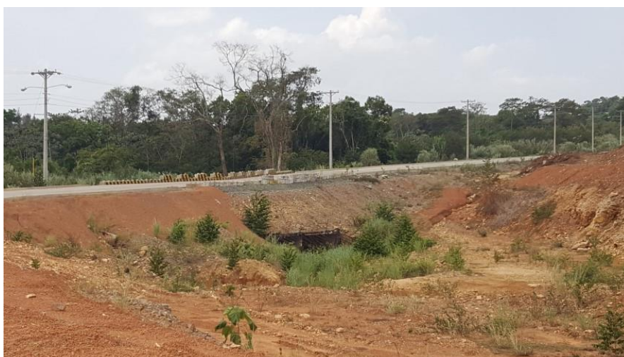
Cajón bajo el bulevar de acceso al proyecto, Quebrada Limón
