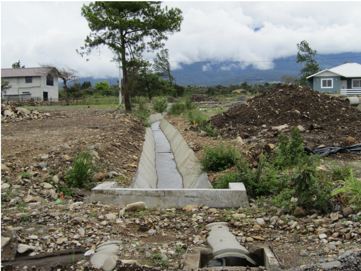
Figura 6. Desagües de concreto.
