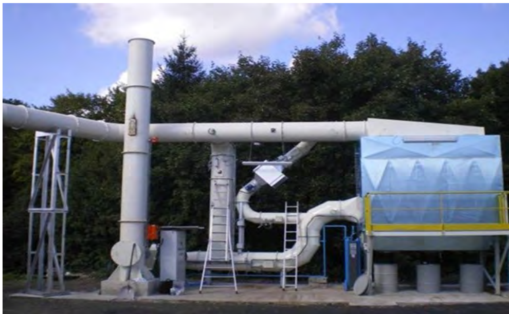
Ilustración N° 28. Sistema de control de emisiones para horno rotatorio. Fuente: HORMESA AMERICA LTDA (Colombia).
