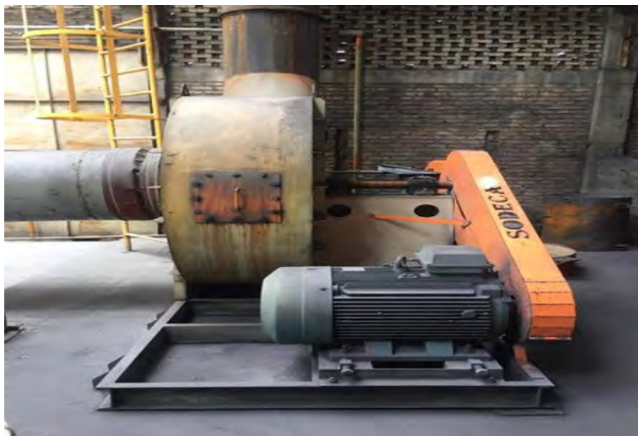
Ilustración N° 30. Ventilador centrífugo. Fuente: Productora Nacional de Metales S.A.S.
