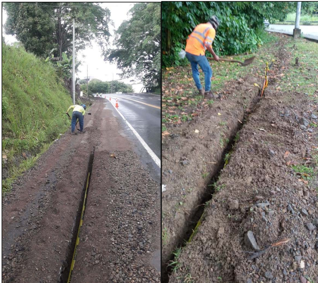
Figura #7 y 8. Vista del zanjado a realizarse para la instalación de la fibra óptica. Fuente: promotor.
