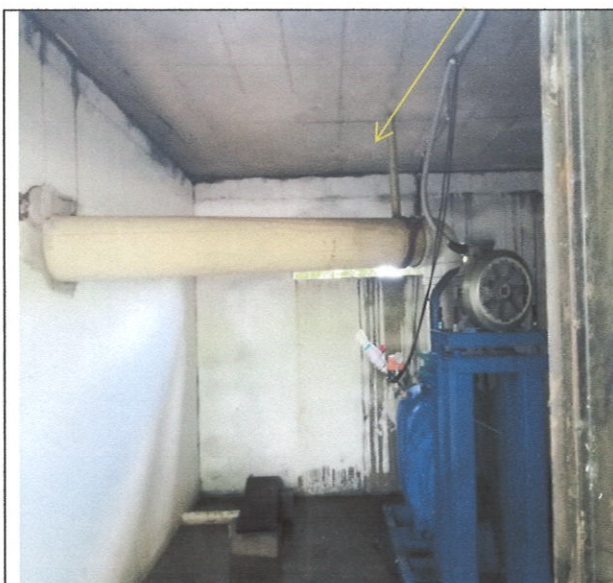
Foto 7. Vista de la bomba de captación de agua.
