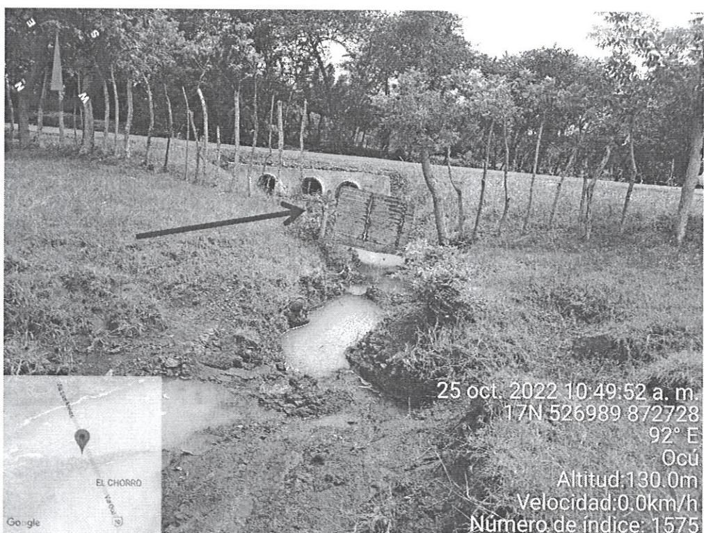
**Fig. No. 6:** Vista del drenaje pluvial, cercano al área del proyecto, el cual discurre hacia tuberías transversales ubicadas en la Carretera Ocú – Las Minas.
