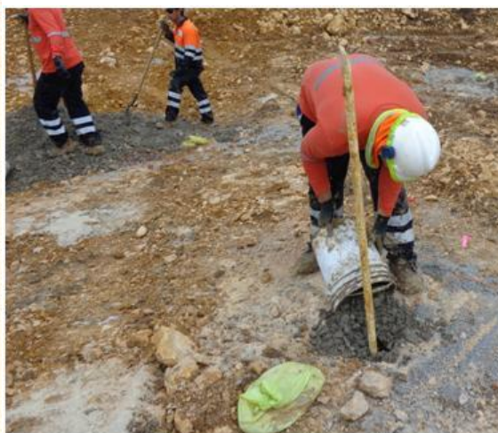
Tapado de pozos utilizando stemming
