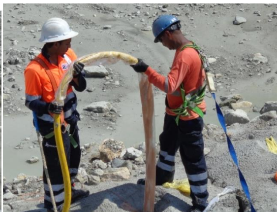
Bombeo de Explosivo a bolsa de polietileno
