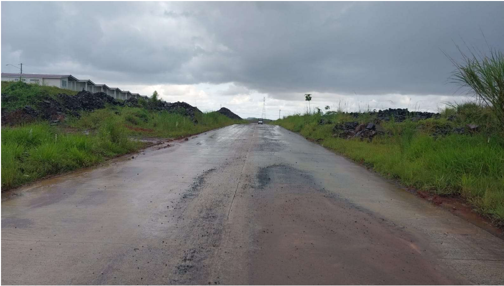
Calle 28, Brisas del Golf Arraijan a 350+ metros
