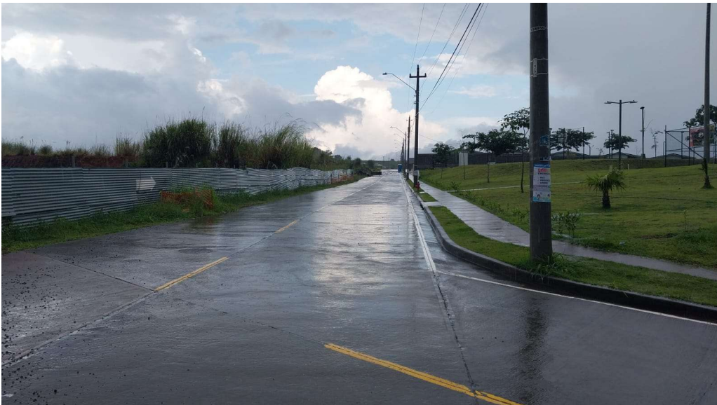
Calle 24, Brisas del Golf Arraijan a 350+ metros
