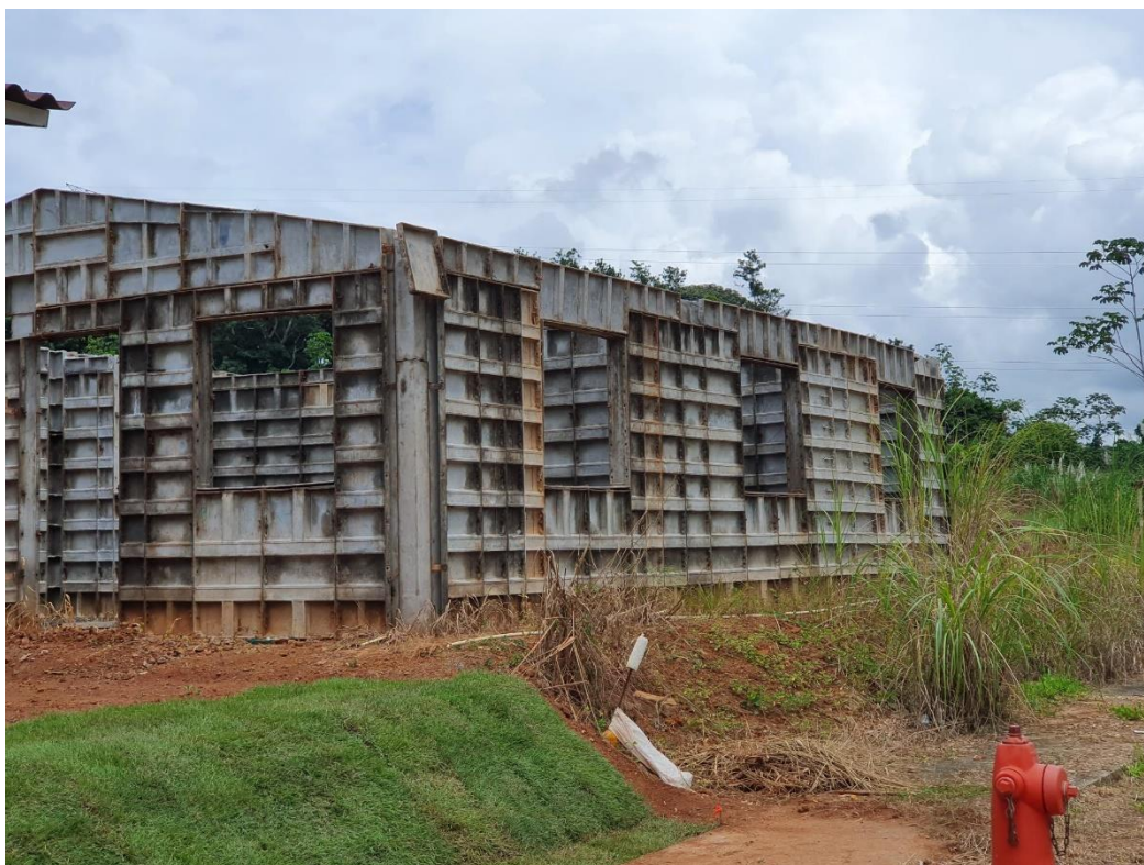
Sistema constructivo con moldes de aluminio procurando la construcción de las casas en menor tiempo.
