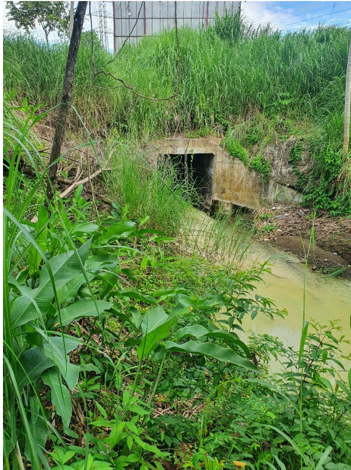
Foto No. 6.3-1. Salida de las aguas de la quebrada Gran Diablo. Cajón pluvial doble.
