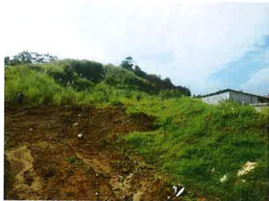
Foto N° 2: Tramo prospectado. Alteración por corte y corte.
