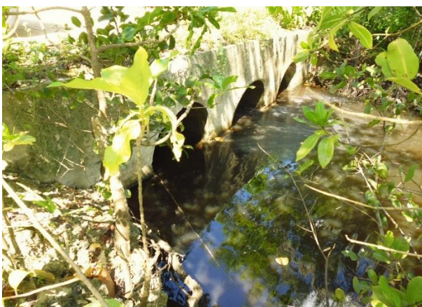
Foto 3. Material obstruyendo el cajón pluvial.
