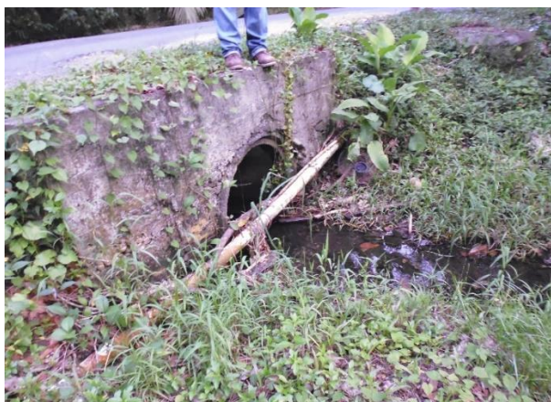
Foto 3. Material obstruyendo el cajón pluvial.
