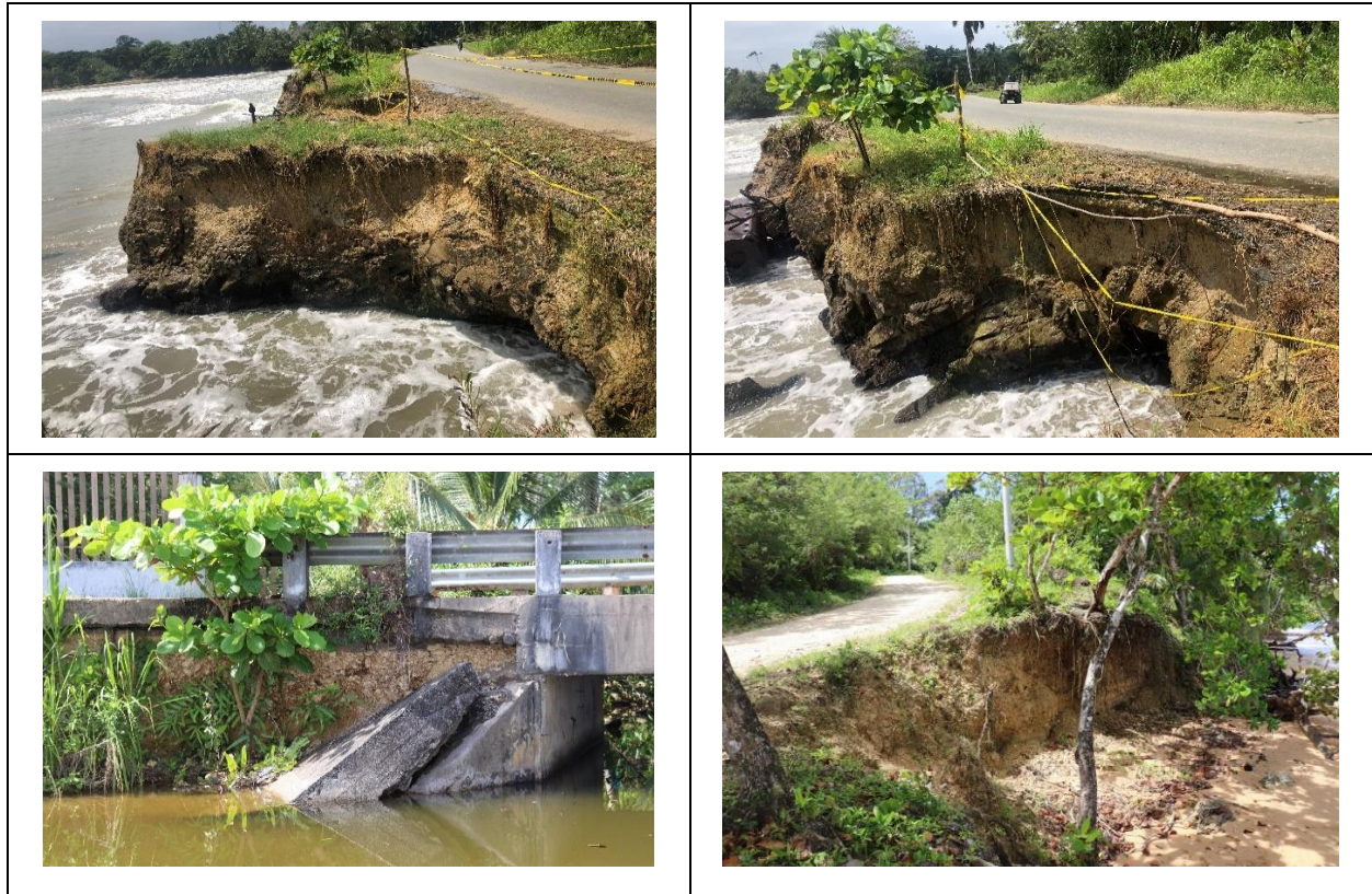
Ilustración 1. Área de erosión en la Fase B del proyecto.
