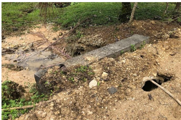
Foto 4. Tubería de drenaje con rupturas por el paso vehicular.
