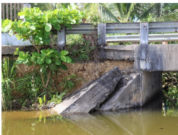
Foto 1. Parte de estructura de puente colapsada
