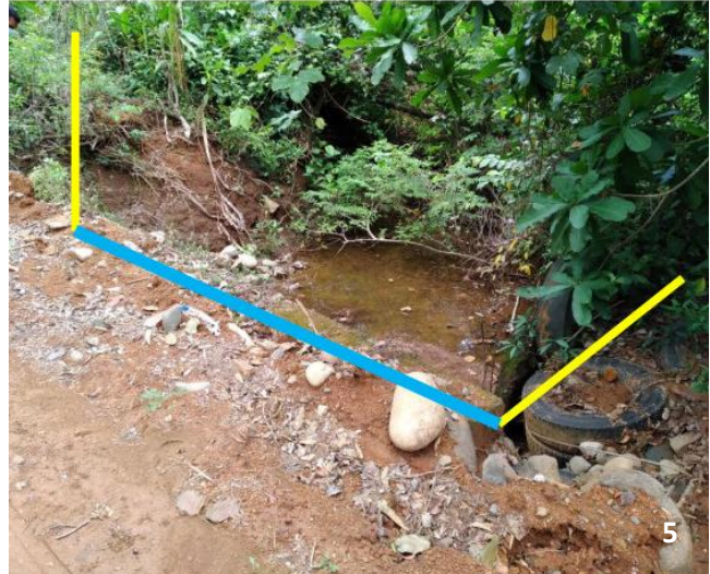
Se construirá aletas tipo zampeado para control de la erosión y mejor conducción de las aguas pluviales provenientes de las cunetas
