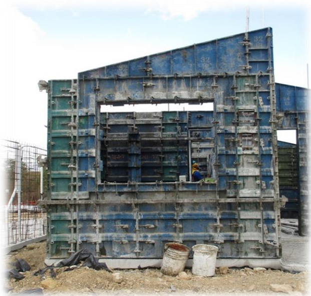
Fotografía 6 Moldes metálicos para encofrado
