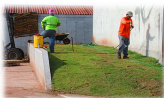
Fotografía 7 Colocación de grama sobre suelos desnudos
