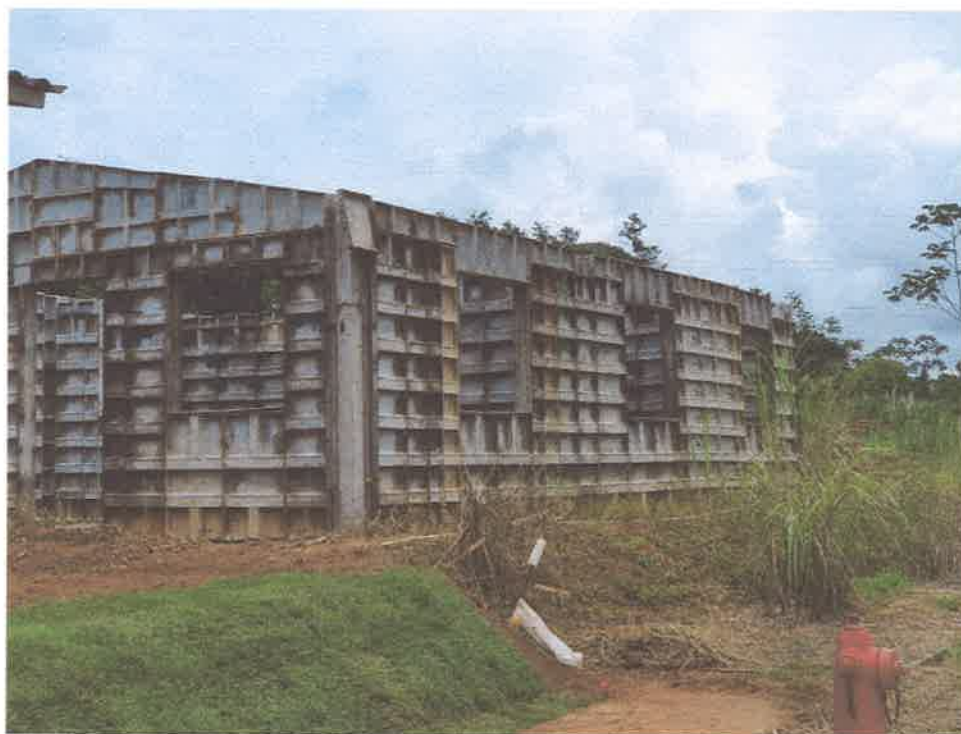
Sistema constructivo con moldes de aluminio procurando la construcción de las casas en menor tiempo.
