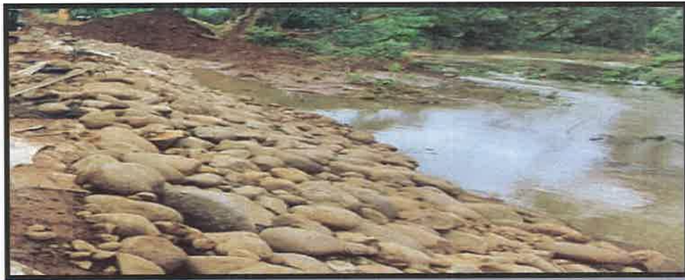
Sistema de muro de contención mediante muro de enrocado.
