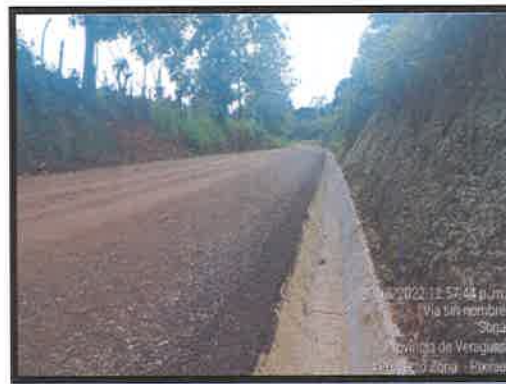
Capa base colocada en la calzada
