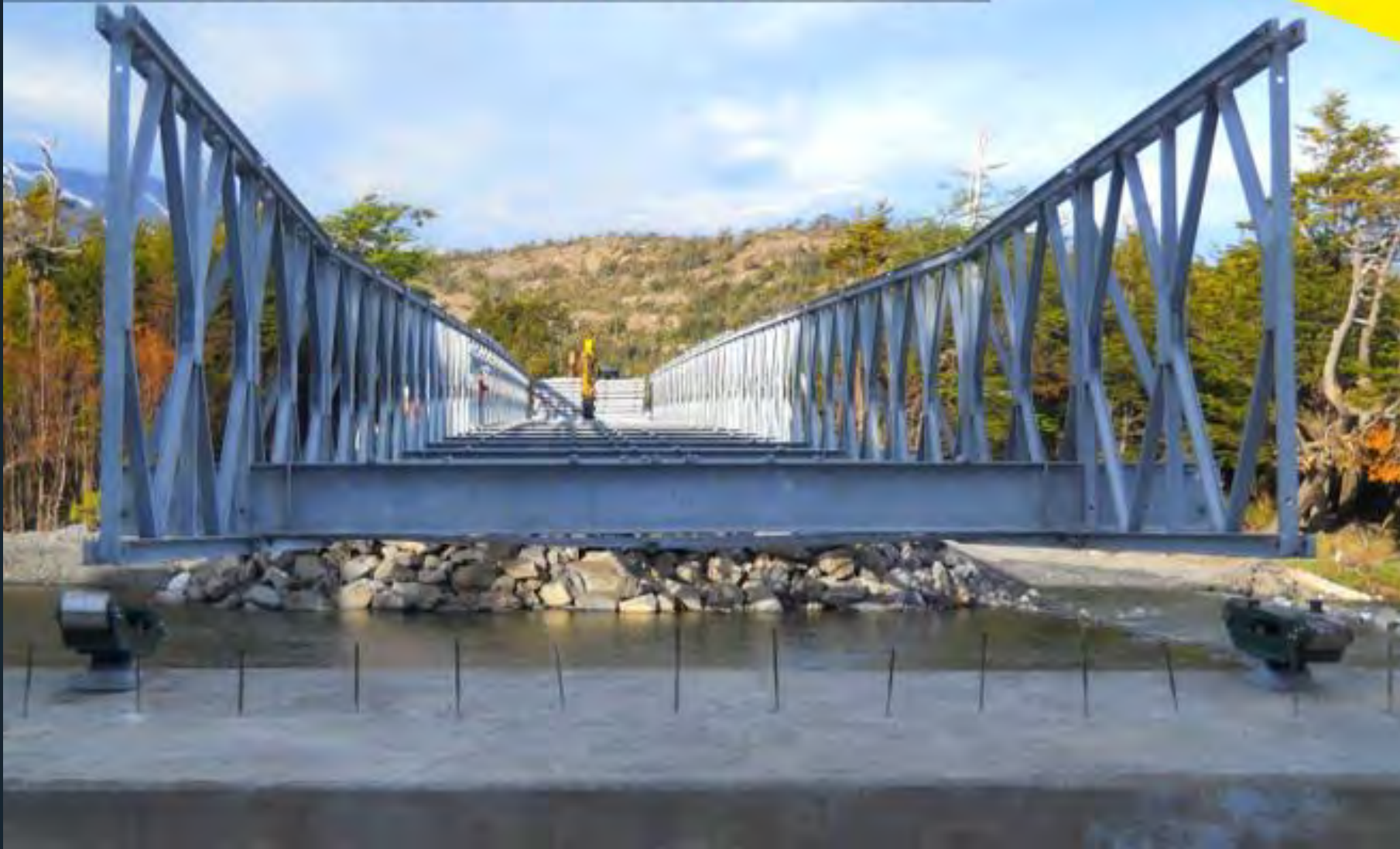
LLEGADA DE LA NARIZ DE LANZAMIENTO A LA ORILLA OPUESTA
