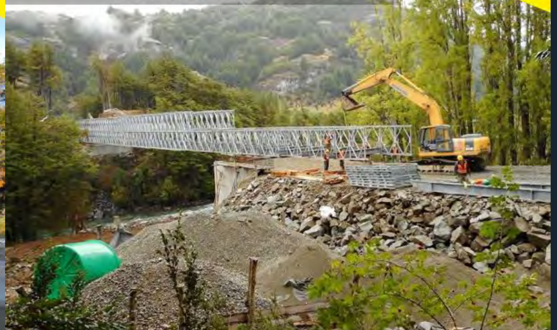
DESMONTAJE DE LA NARIZ DE LANZAMIENTO
