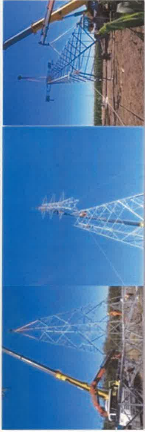
Pre-armado de torres en el suelo: Apoyo completo y por tramo.
