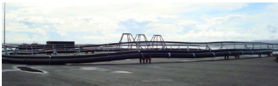
Fig. 5.5.7. Anillo de superficie flexible de 50m de diámetro y 500mm bajo construcción en las instalaciones de Aqualine's en Noruega.
