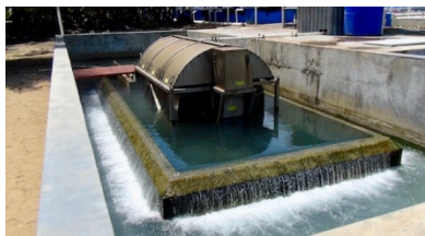
Foto 12. Vistas del tambor rotativo, tratamiento del efluente (diciembre 2014; octubre 2016).
