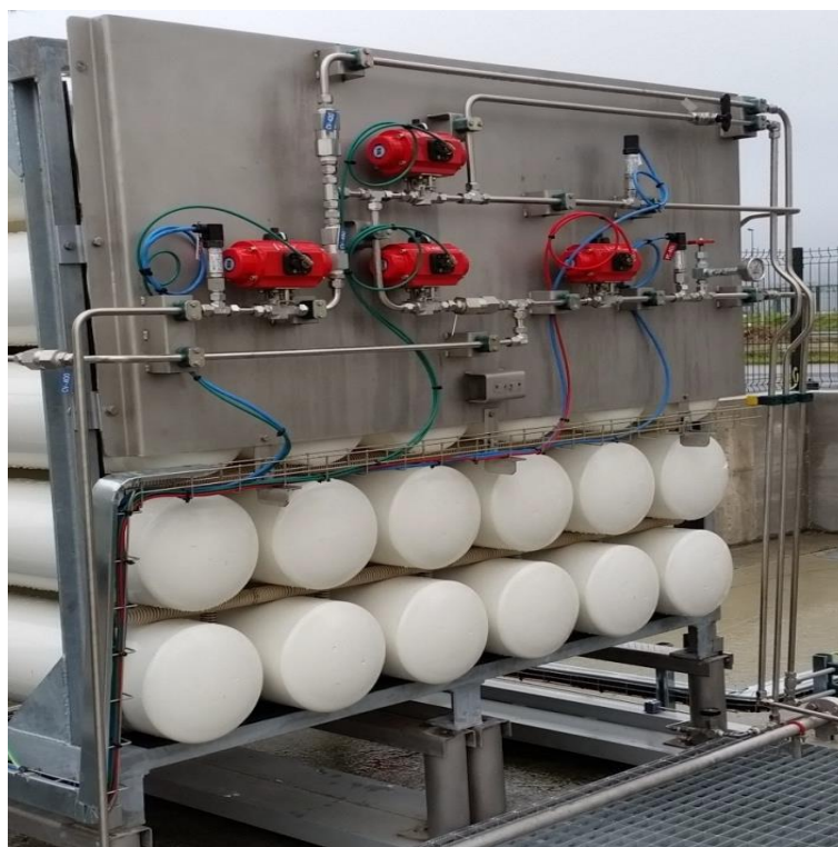
Figura 5-5. Pulmón de botellas GNC 80 litros por cada unidad.
