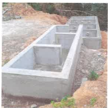
Foto 1 y 2. Diseño de la tina de sedimentación, donde se observan los diferentes compartimientos para sedimentar los sólidos del agua residual.
