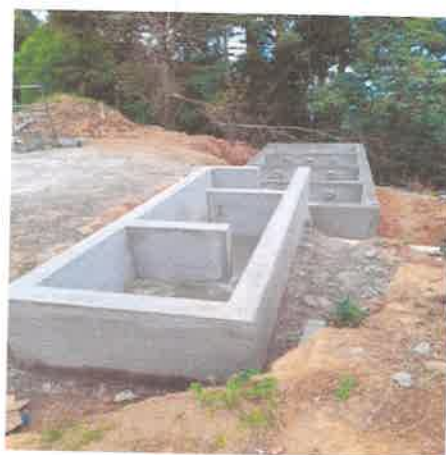
Foto 5. Vista del diseño de aguas residuales. Al frente se encuentra la tina de sedimentación y al fondo la tina de decantación.
