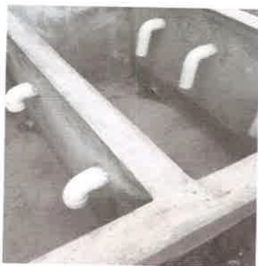
Foto 3 y 4. Vista del diseño de las tinas de decantación, donde se observa el mecanismo de separación de sólidos y agua limpia.
