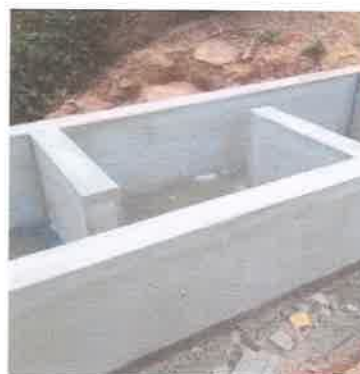
Foto 1 y 2. Diseño de la tina de sedimentación, donde se observan los diferentes compartimientos para sedimentar los sólidos del agua residual.
