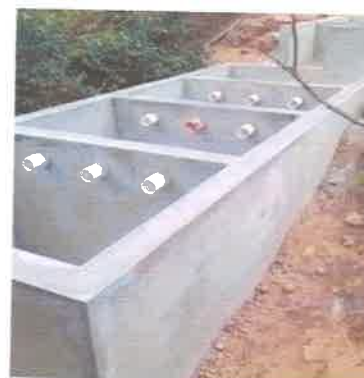
Foto 3 y 4. Vista del diseño de las tinas de decantación, donde se observa el mecanismo de separación de sólidos y agua limpia.
